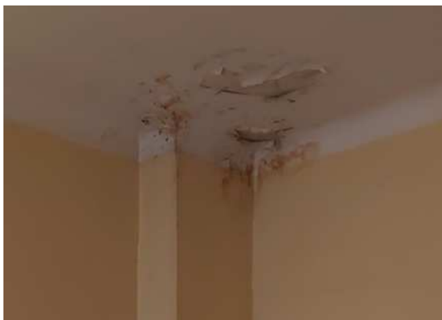
zdjęcie nr 8 Lokalne zawilgocenie stropu
