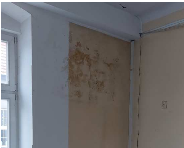
zdjęcie nr 6 Lokalne zawilgocenie ścian od strony wewnętrznej
