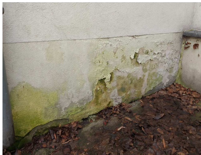
zdjęcie nr 5 Zły stan techniczny tynków zewnętrznych
