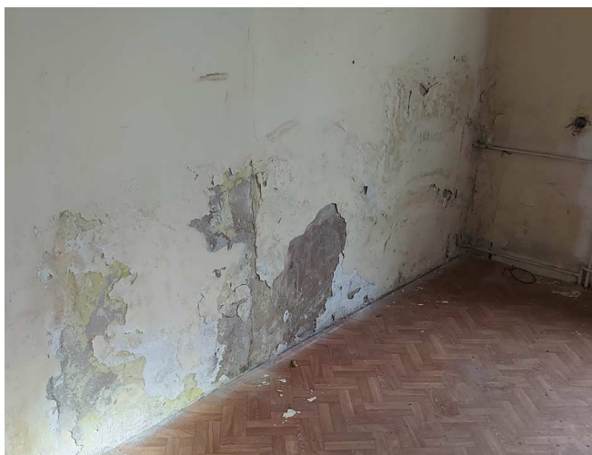
zdjęcie nr 7 Lokalne zawilgocenie ścian od strony wewnętrznej
