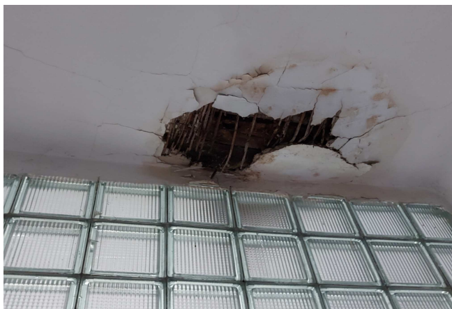
zdjęcie nr 9 Lokalne zawilgocenie stropu i uszkodzone deskowanie i tynk
