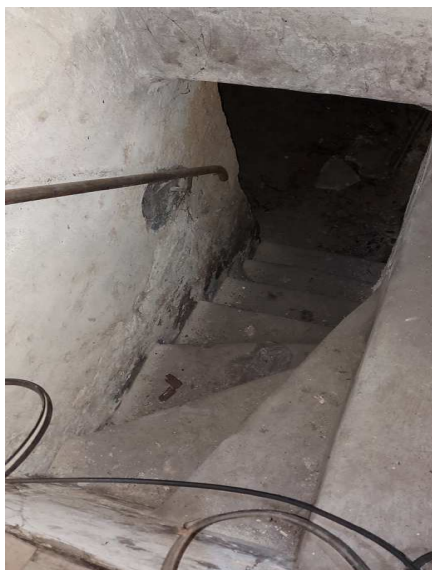
zdjęcie nr 11 Schody betonowe, zabiegowe do piwnicy
