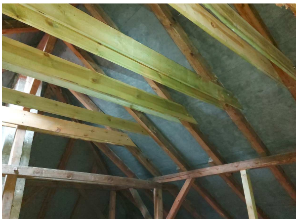
zdjęcie nr 12 Więźba dachowa po remoncie w latach ubiegłych, widoczne nowe elementy konstrukcyjne
