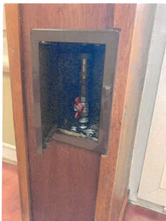
Drzwiczki rewizyjne do instalacji c.o.
