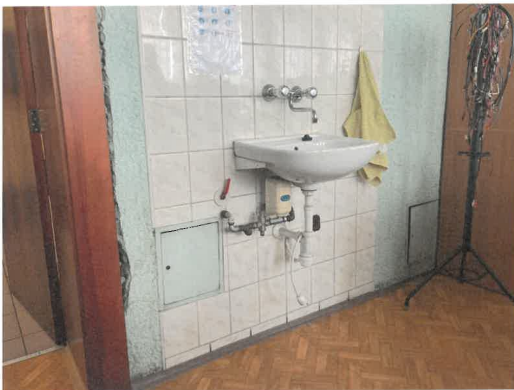
Umywalka z fartuchem z płytek ceramicznych i zestawem zaworów.
