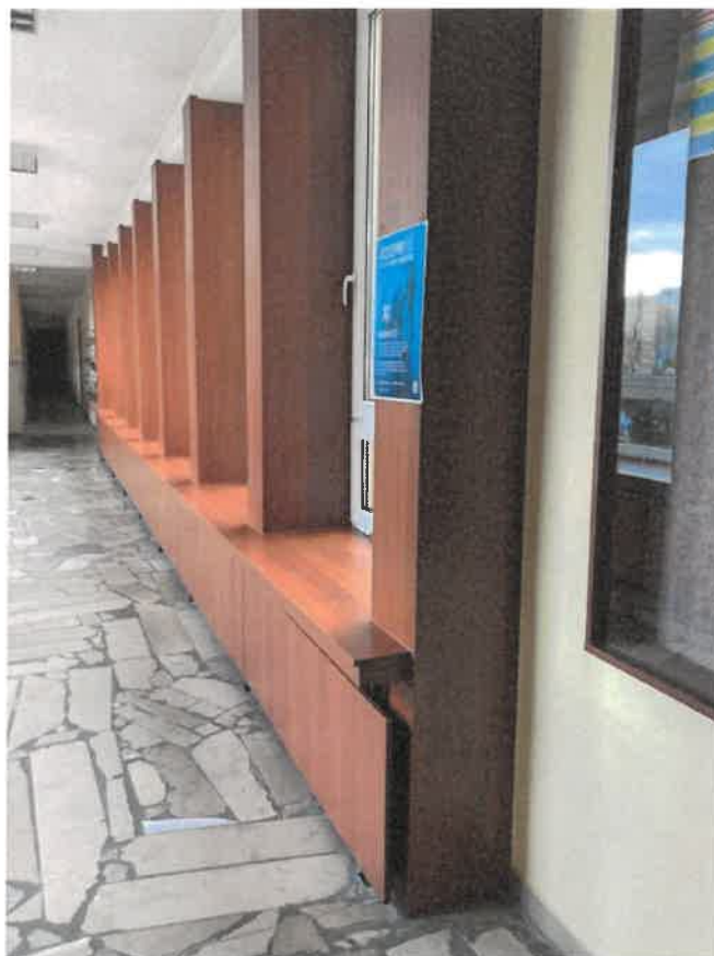
Drzwiczki rewizyjne do instalacji c.o.
