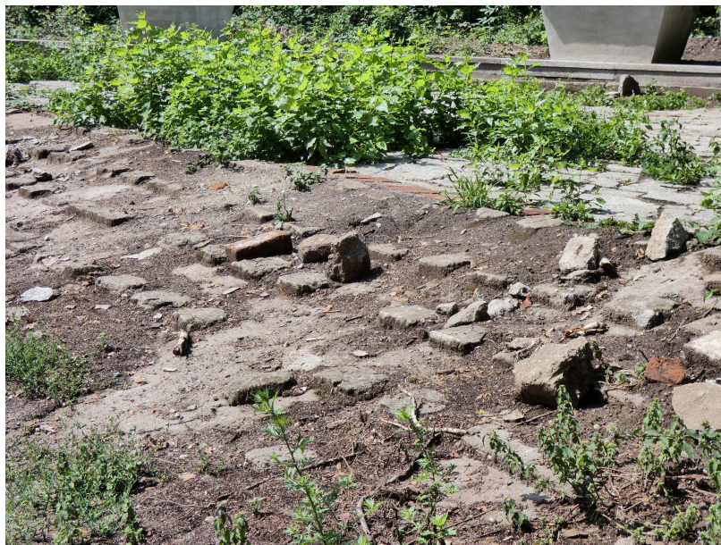
Fot. 7 Widoczny uszkodzony podkład betonowy dawnych schodów /lipiec 2018/
