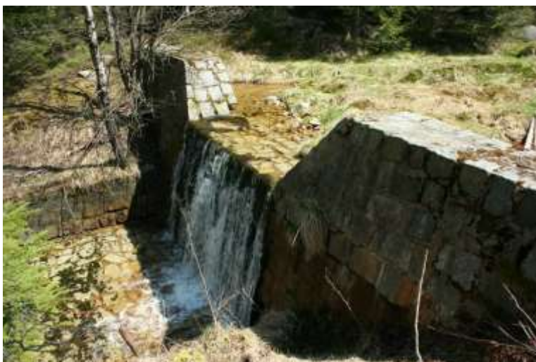
Wypełniona zaporą tworzy wysoki próg – przerwana ciągłość cieku – Nadleśnictwo Szklarska Poręba. Źródło: Archiwum CKPŚ
