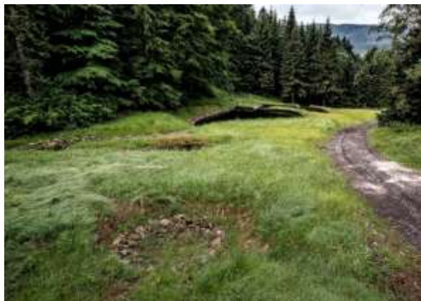
Doły chłonne i kałuże przejmujące wodę odprowadzaną rowkami z drogi. Warto zwrócić uwagę, że sytuacja terenowa położenia drogi względem cieku bardzo sprzyja odprowadzeniu wody z drogi wospustami i dolotami także do zbiorników widocznych poniżej. Źródło: Archiwum CKPŚ.
