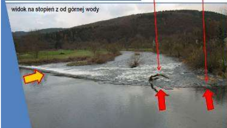
Bystrze dwuspadowe na stopniu poniżej mostu (Jelonek 2008)
