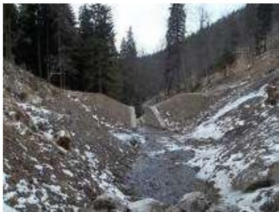
Suchy zbiornik w I-ctwie Jawornica z przelewem szczelinowym (przepławką) (fot. N-ctwo Międzyzlesie)
