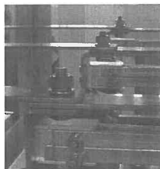
Fot. 2.1 Rotoblok, Połączenie toru szynowego ze stykiem rozłącznika
