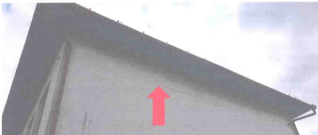
Fot.3. Pęknięcie ściany na na wysokości stropu nad piętrem
