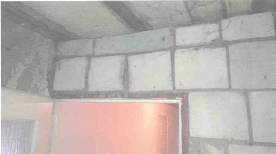
Fot.6. Ściana działowa poddasza – nadproże nad drzwiami
