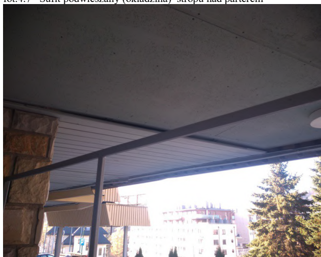
fot.4.7 Sufit podwieszany (okładzina) stropu nad parterem
