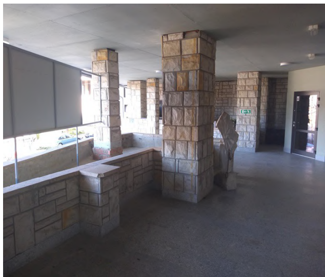
fot.4.7 Sufit podwieszany (okładzina) stropu nad parterem
