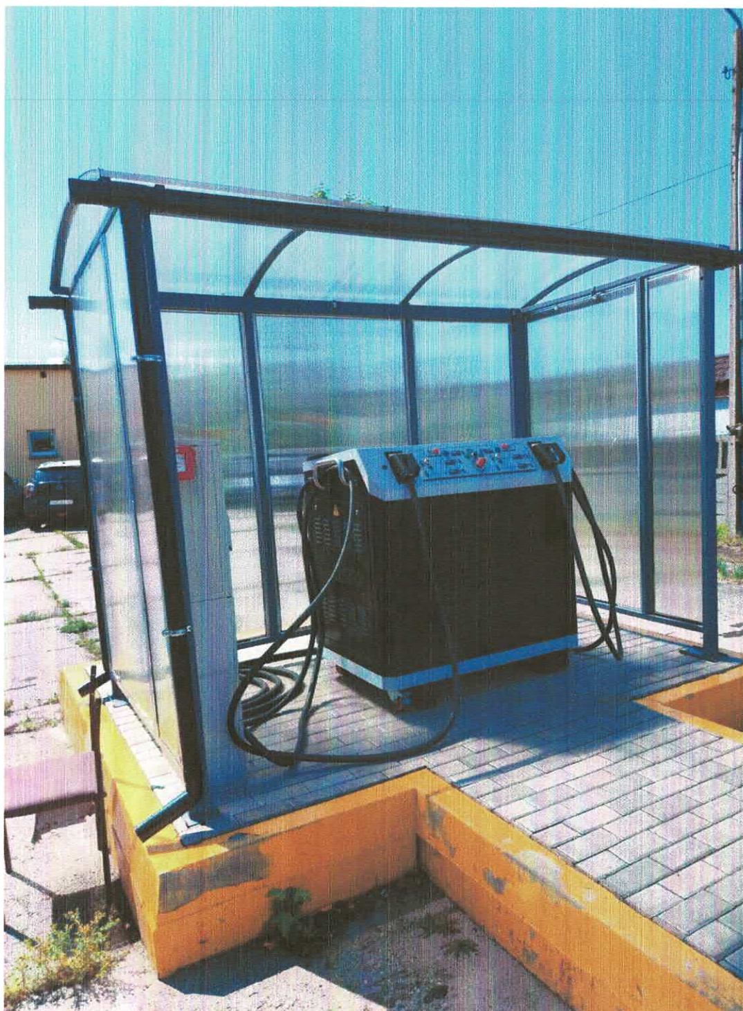
Rysunek 9 Przykładowe posadowienie stacji ładowania typu plug - in
