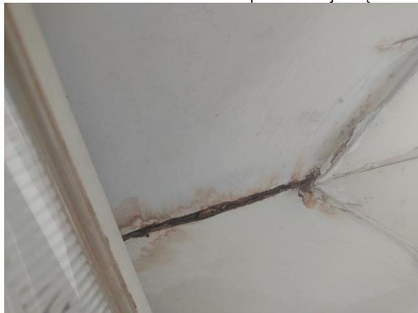
Wyraźne zawilgocenie płyt sufitowych w pomieszczeniu trenera.
