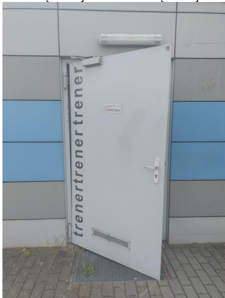
Wyrwane skrzydło drzwiowe z zawiasu górnego
