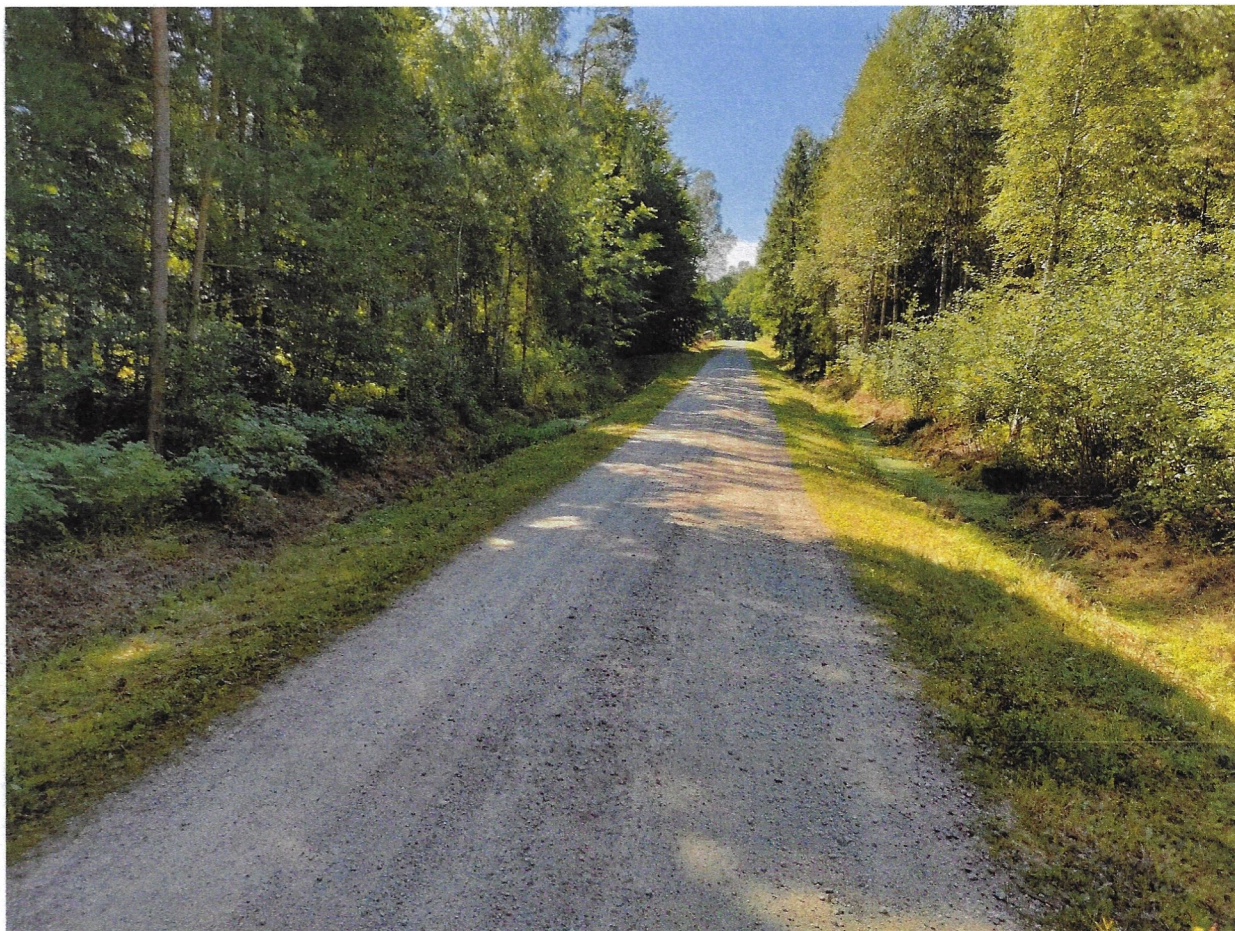
Fot. 1. Przedmiotowy odcinek drogi leśnej z widocznym zaniżeniem nawierzchni
