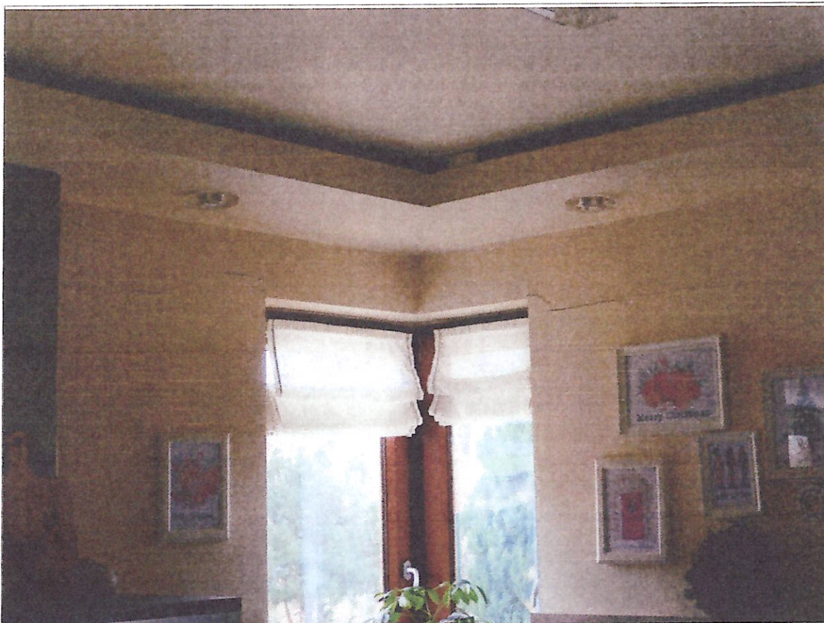
Pęknięcia wewnątrz budynku
