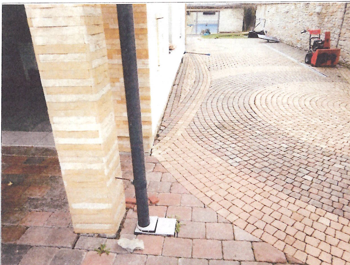
Deformacje i szczeliny w otoczeniu budynku
