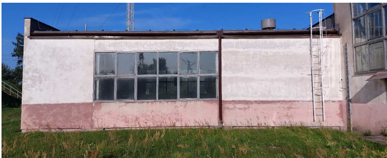
Fot. 3. Elewacja wschodnia – nawa II (Okno do wymiany oraz częściowe zamurowanie otworu, ściana do ocieplenia, rynny i rury spustowe do wymiany)
