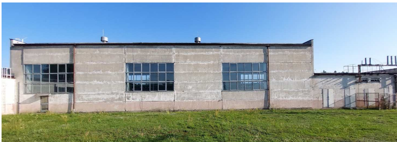
Fot. 4. Elewacja południowa – nawa III i IV (Stolarka okienna i drzwiowa do wymiany, zmniejszenie otworów okiennych, likwidacja jednego otworu drzwiowego, ściany do ocieplenia, rynny i rury spustowe do wymiany)
