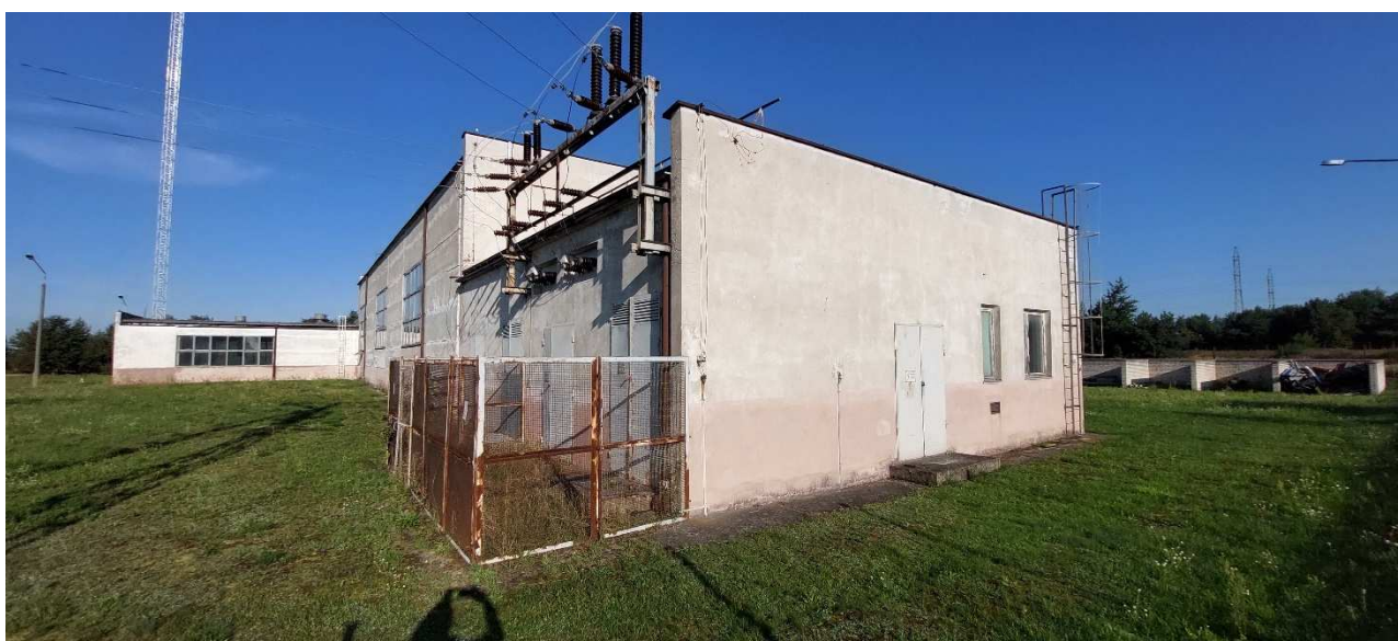
Fot. 5. Elewacja wschodnia – nawa IV (Stolarka okienna i drzwiowa do wymiany, ocieplenie ścian, ocieplenie ściany szczytowej nawy III, wymiana ogrodzenia na nowe, wykonanie nowej obróbki attyki x2)
