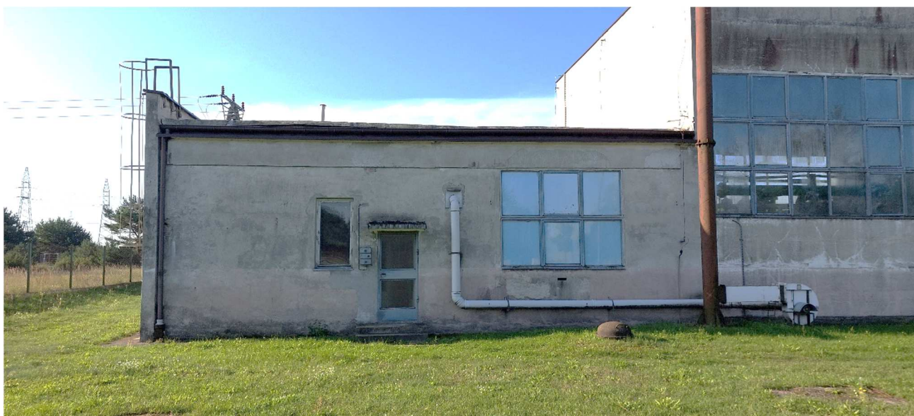
Fot. 6. Elewacja północna – nawa IV (Stolarka okienna i drzwiowa do wymiany, częściowe zmniejszenie otworu okiennego, ocieplenie ścian, czyszczenie i malowanie komina, wymiana daszka na drzwiach, wymiana rynien i rur spustowych, odsunięcie instalacji wentylatora od ściany,)
