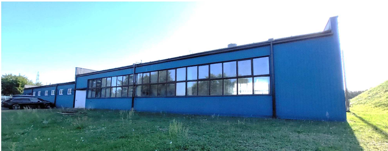
Fot. 1. Elewacja zachodnia – nawa II (Stolarka okienna do wymiany oraz do częściowego zamurowania, elewacja z blachy do demontażu, ściany do ocieplenia, wykończenie z wyprawy elewacyjnej, wymiana rynien i rur spustowych)
