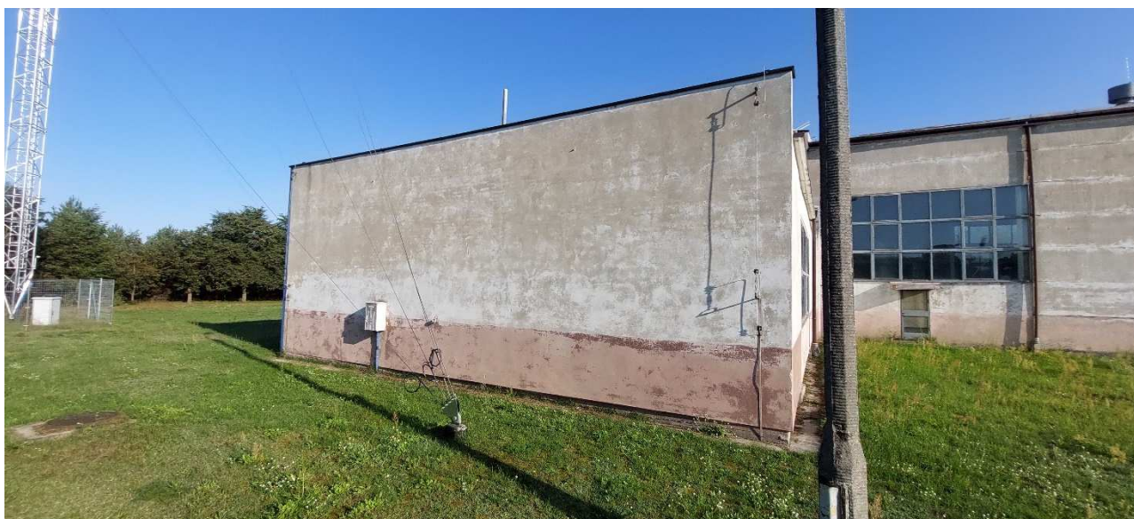
Fot. 2. Elewacja południowa – nawa II (Elewacja do ocieplenia – styropian gr. 10 cm, wykonanie nowej obróbki attyki)
