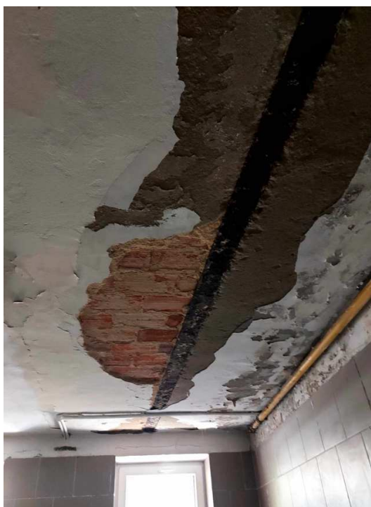
zdjęcie nr 8 – Strop nad piwnicą typu Klein. Widoczna korozja oraz ubytki tynku na suficie
