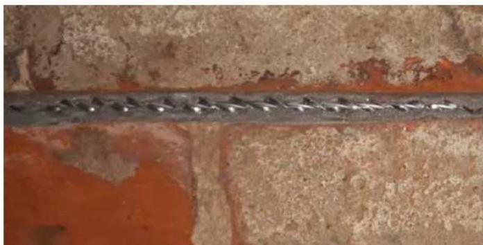
Przykład zbrojenia helikalnego
