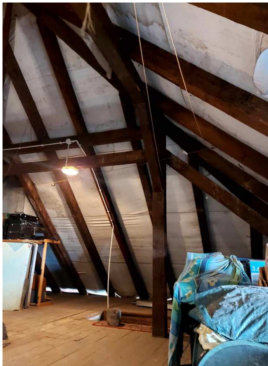
zdjęcie nr 7 – Widok na poddasze i więźbę dachową. Drobne zacieki widoczne na membranie
