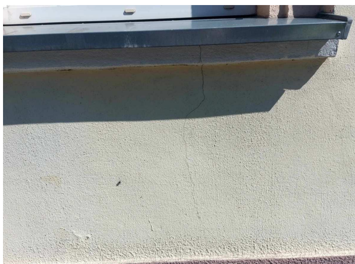
zdjęcie nr 11 – Drobne zarysowania na ścianach zewnętrznych widoczna na elewacji frontowej
