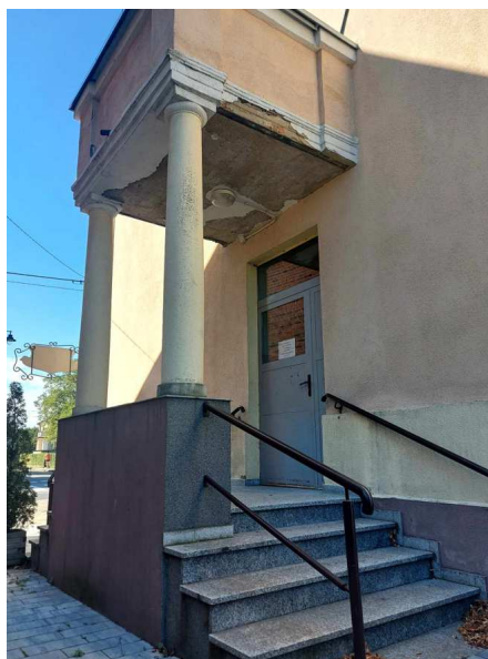
zdjęcie nr 4 – Widok na schody wejściowe i balkon wsparty na dwóch filarach. Widoczne ubytki tynku powstałe w wyniku przeziąkania wody przez balkon.
