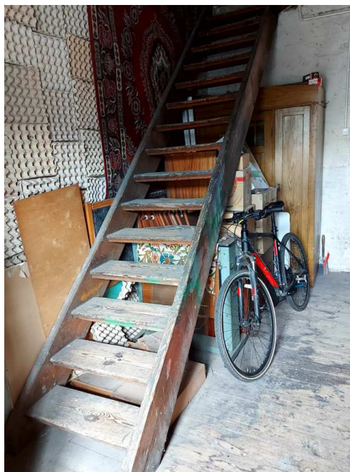
zdjęcie nr 6 – Schody na poddasze w konstrukcji drewnianej bez balustrady.
