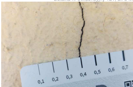
zdjęcie nr 12, 13 – Pomiary drobnych zarysowań na ścianach nośnych na poziomie parteru
