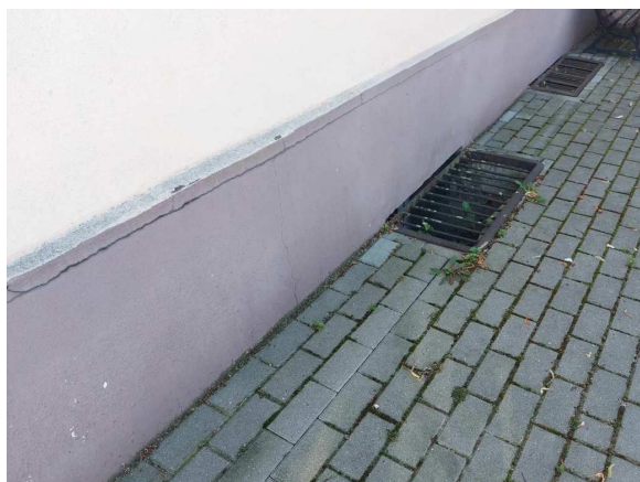
zdjęcie nr 14 – Pęknięcia poziome na cokole widoczne na elewacji tylnej
