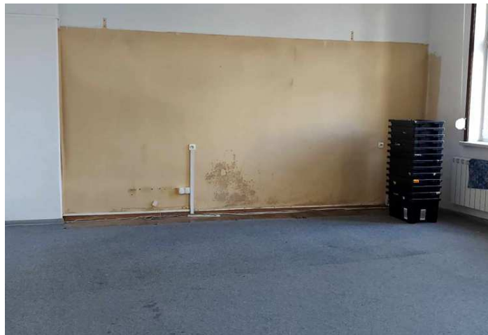
zdjęcie nr 10 – Zawilgocenie ścian zewnętrznych na poziomie parteru
