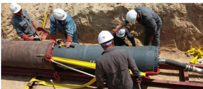
Rys. 28. Przecisk z ubijakiem umieszczonym za rurą stalową
