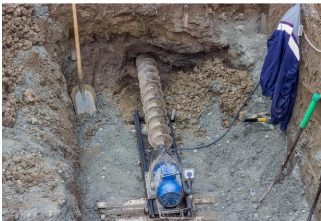
Rys. 30. Wykonywanie przewiertu
