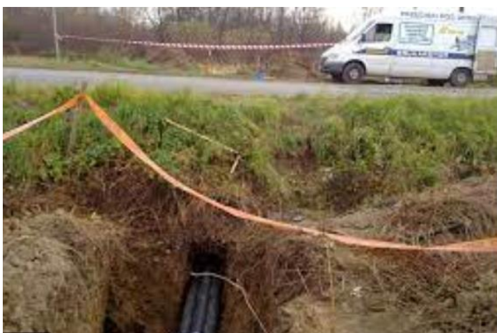
Rys. 31. Kanał kablowy umieszczony metodą przewiertu
