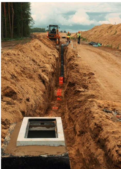
Rys. 34. Zamontowana studzienka kablowa
