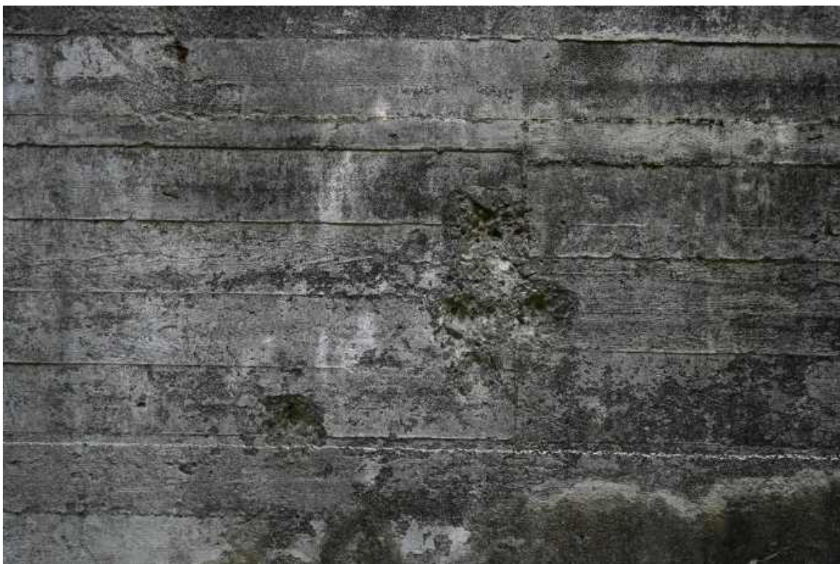
39. Fragment elewacji południowej (komora schronowa), prawdopodobne ślady po pociskach.
