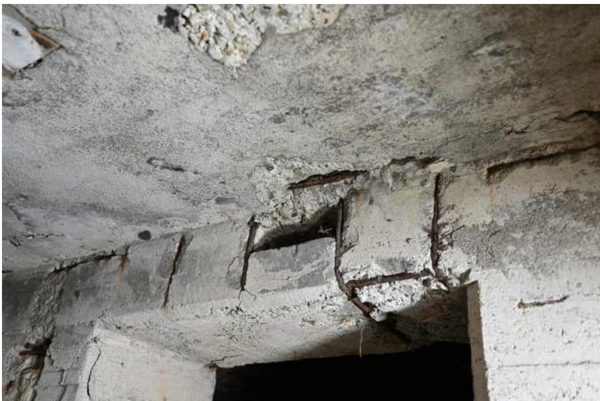
77. Ściana południowa przedsionka, przejście do komory schronowej, otwór do przeprowadzenia instalacji elektrycznej. Widoczne duże odspojenie betonu i odsłonięte zbrojenie.
