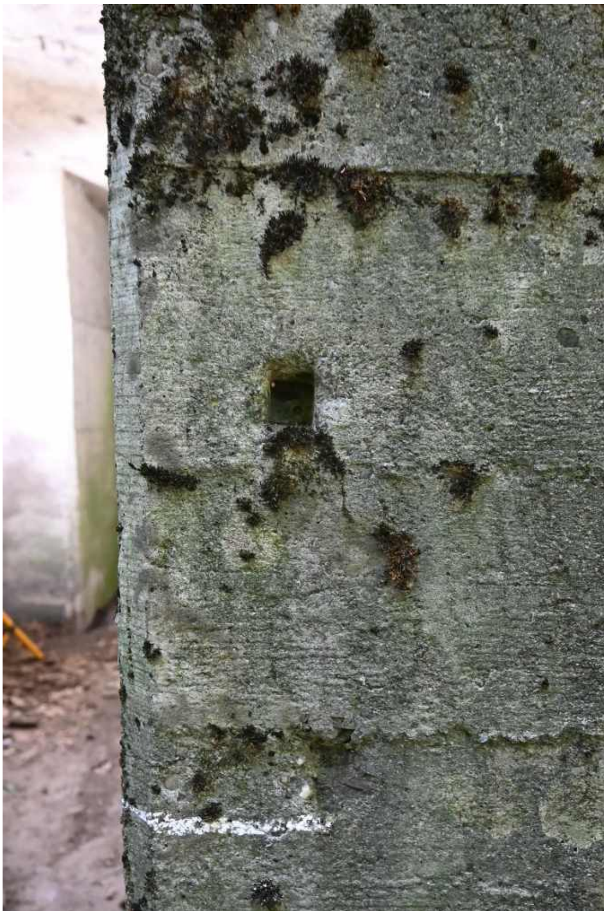
53. Wejście północne, otwór po drewnianym kołku służącym do zamocowania zamknięcia drzwi.
