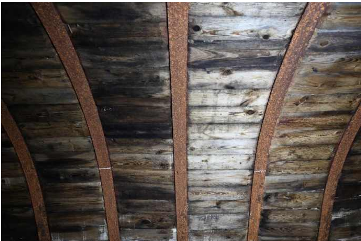
93. Wewnętrzne wypełnienie ścian komory schronowej.
