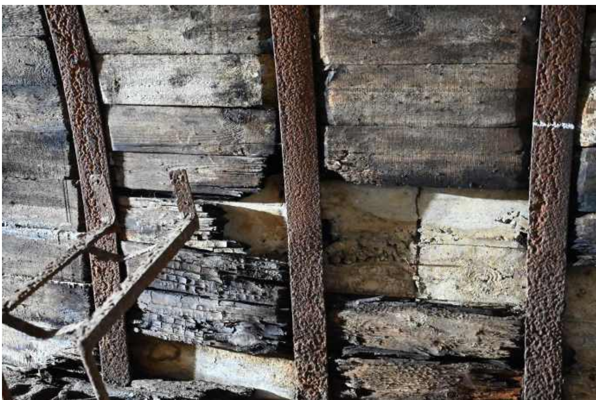
118. Ściana komory schronowej, nadpalone deski oraz przestrzeń pozbawione szalunków.
