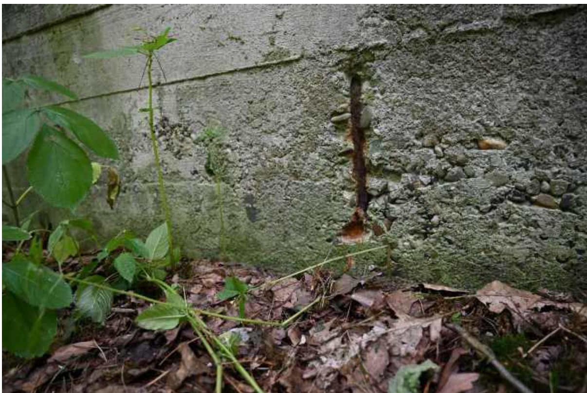
32. Fragment elewacji wschodniej (budynek wejściowy), odsłonięte zbrojenie.
