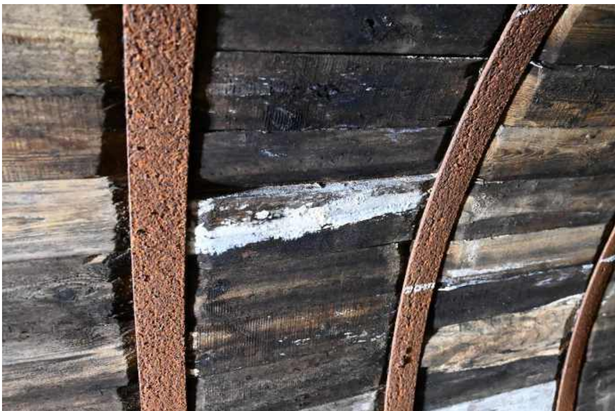
95. Zawilgocone i spleśniałe drewno szalunku wewnętrznego.
