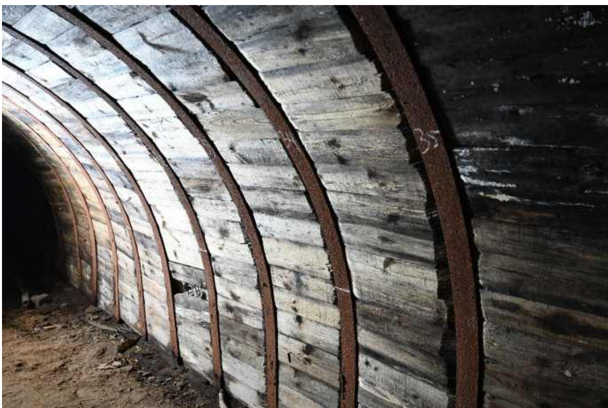
94. Wewnętrzne wypełnienie ścian komory schronowej.
