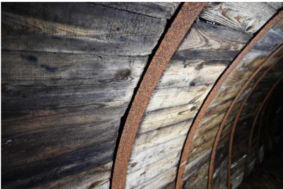
115. Półpierścień komory schronowej silnie skorodowane.
