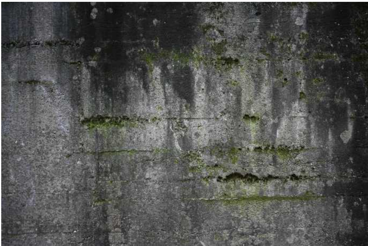
26. Fragment elewacji północnej (budynek wejściowy), widok na ślady po szalunku.
