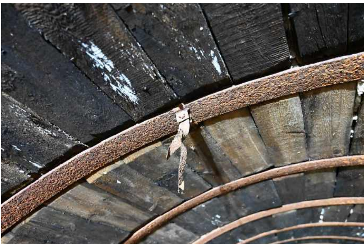
96. Uchwyty od prawdopodobnie wewnętrznego kanały wentylacyjnego rozprowadzającego oczyszczone powietrze.
