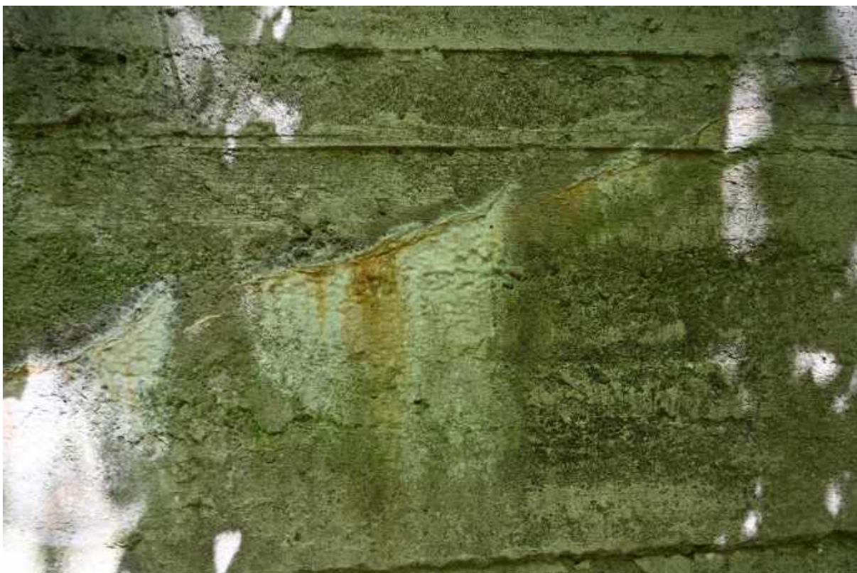
111. Szczelina z wyraźnym wysoleniem.
