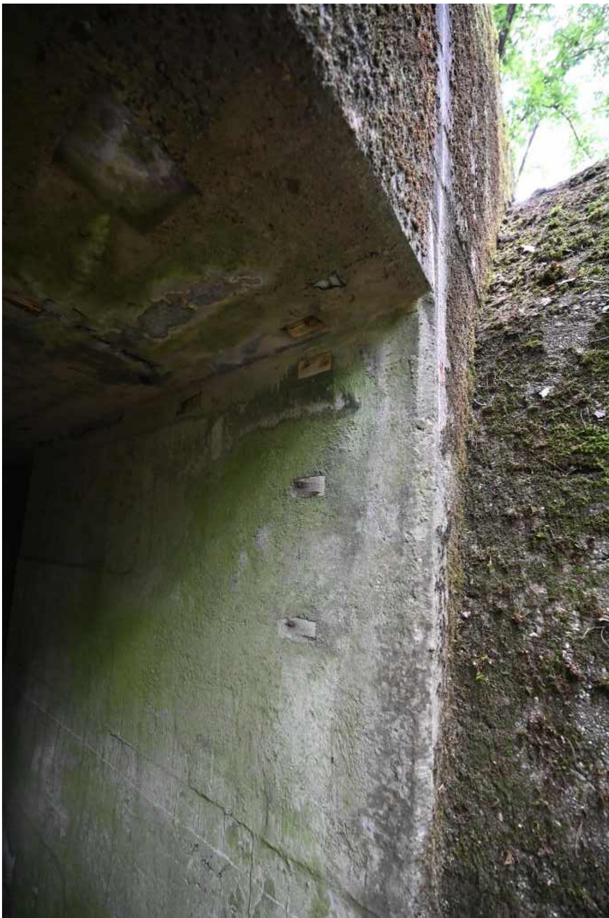
58. Deseczki wmontowane w mur betonowy służące do zamocowania instalacji elektrycznej (oświetleniowej) – kabla, puszki (na suficie) oraz włącznika.
