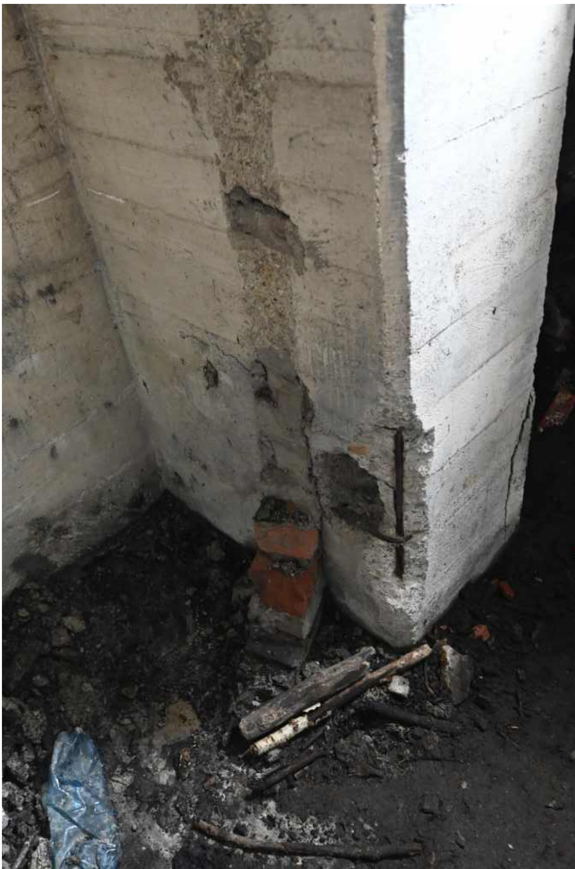
73. Ściana południowa przedsionka, widoczny relikwyt wtórnej ściany ceglanej, gniazda po drewnianych mocowaniach zawiasów oraz odsłonięte zbrojenia.
