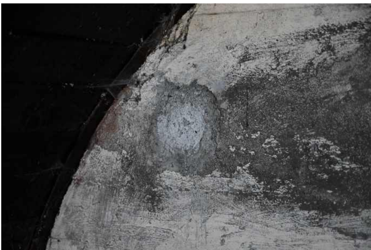
102. Ściana północna komory schronowej, wtórnie wykuty otwór na rurę, która została później obcięta i zamurowana.
