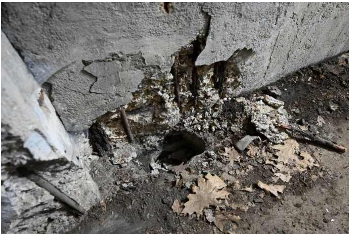
82. Ściana północna przedsionka, przy przejściu do przelotni, niezidentyfikowany otwór w posadzce oraz mocne spękanie betonu.
