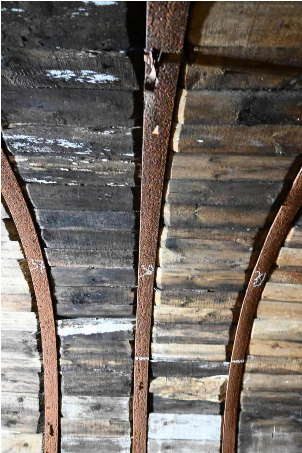
92. Półpierścienie podtrzymujące szalunek drewniany. Widoczny stan zachowania elementów metalowych i drewna.
