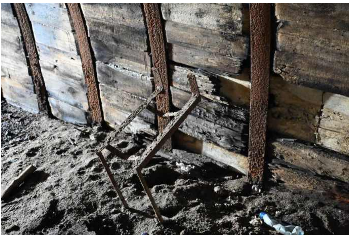
116. Podstawa urządzenia filtrowentylacyjnego wymagająca zabezpieczenia.
