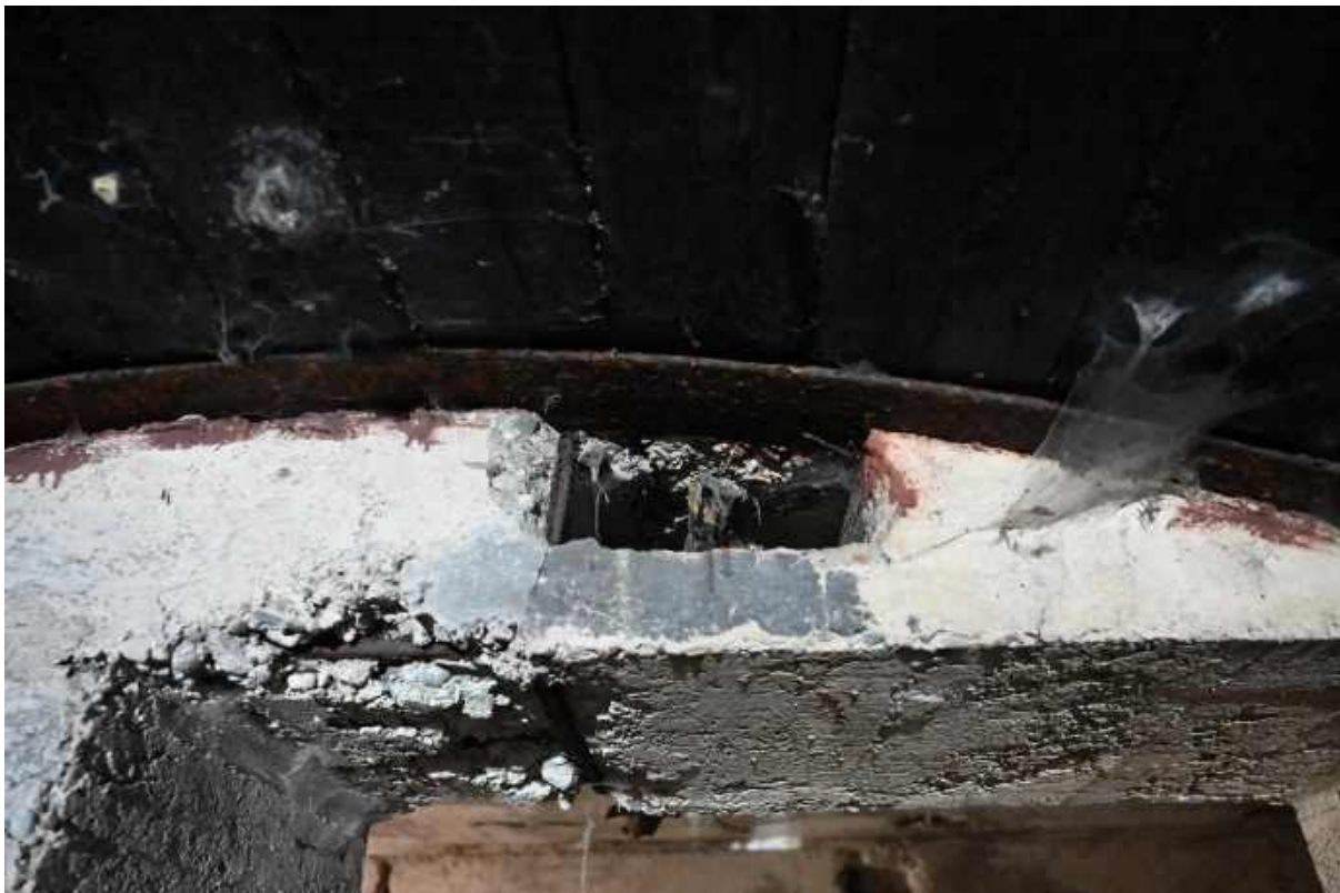
100. Ściana północna komory schronowej, przejście do przedsionka, otwór do przeprowadzenia instalacji elektrycznej. Widoczne duże odspojenie betonu i odsłonięte zbrojenie.
