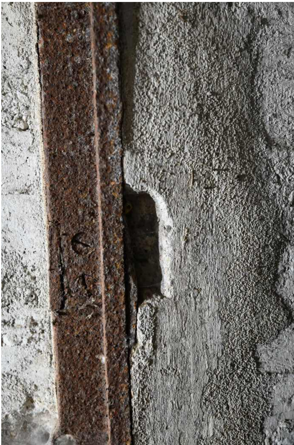
64. Profil ościeżnicy oraz otwór na rygiel drzwi.
