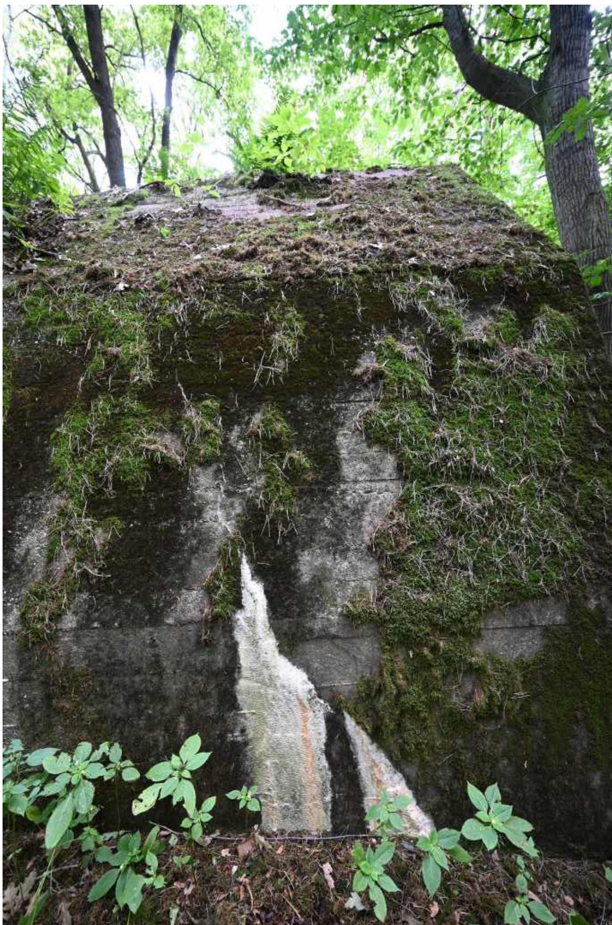
113. Szczelina z wyraźnym wysoleniem.
