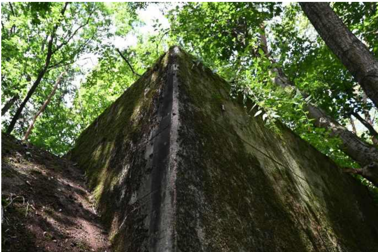
28. Fragment elewacji wschodniej (budynek wejściowy), południowo-wschodnie naroże budynku wejściowego, widoczne sfazowanie.
