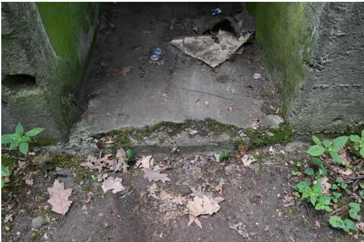
59. Uszkodzenia posadzki betonowej w wejściu północnym.
