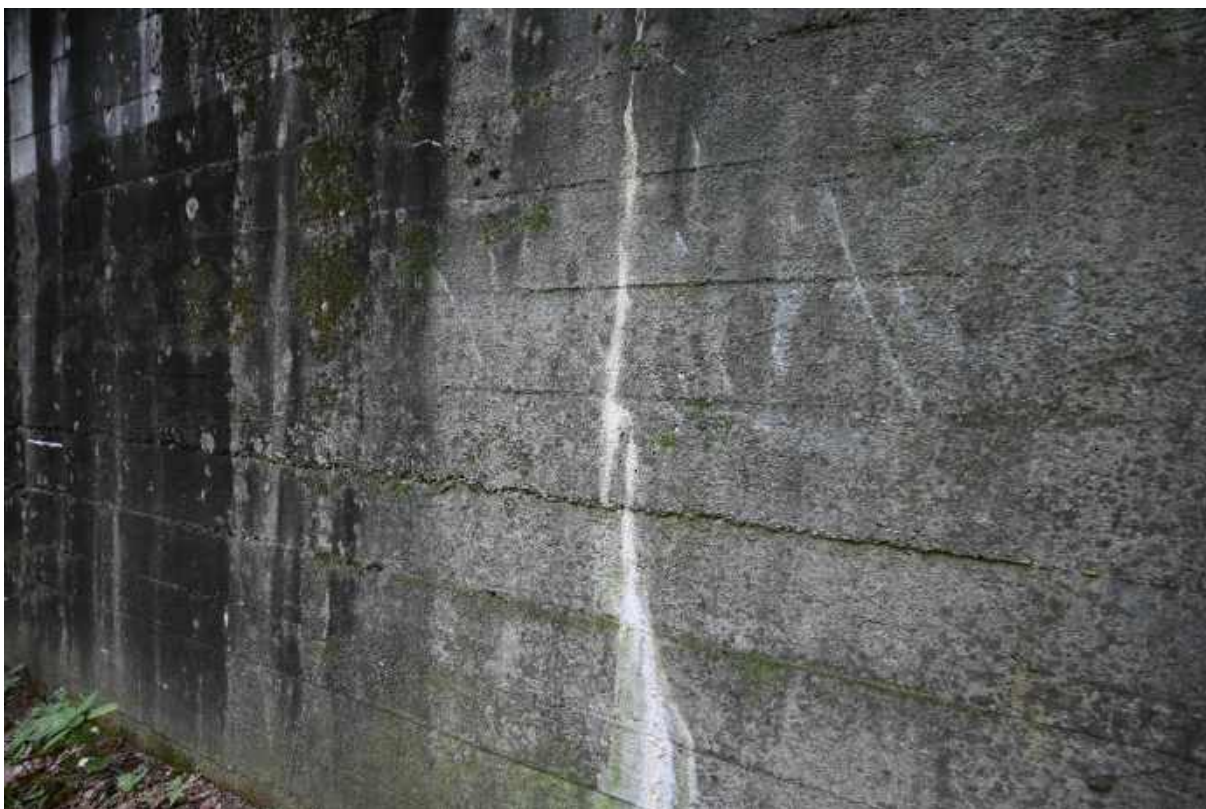
27. Fragment elewacji północnej (budynek wejściowy), widok na ślady po szalunku.
