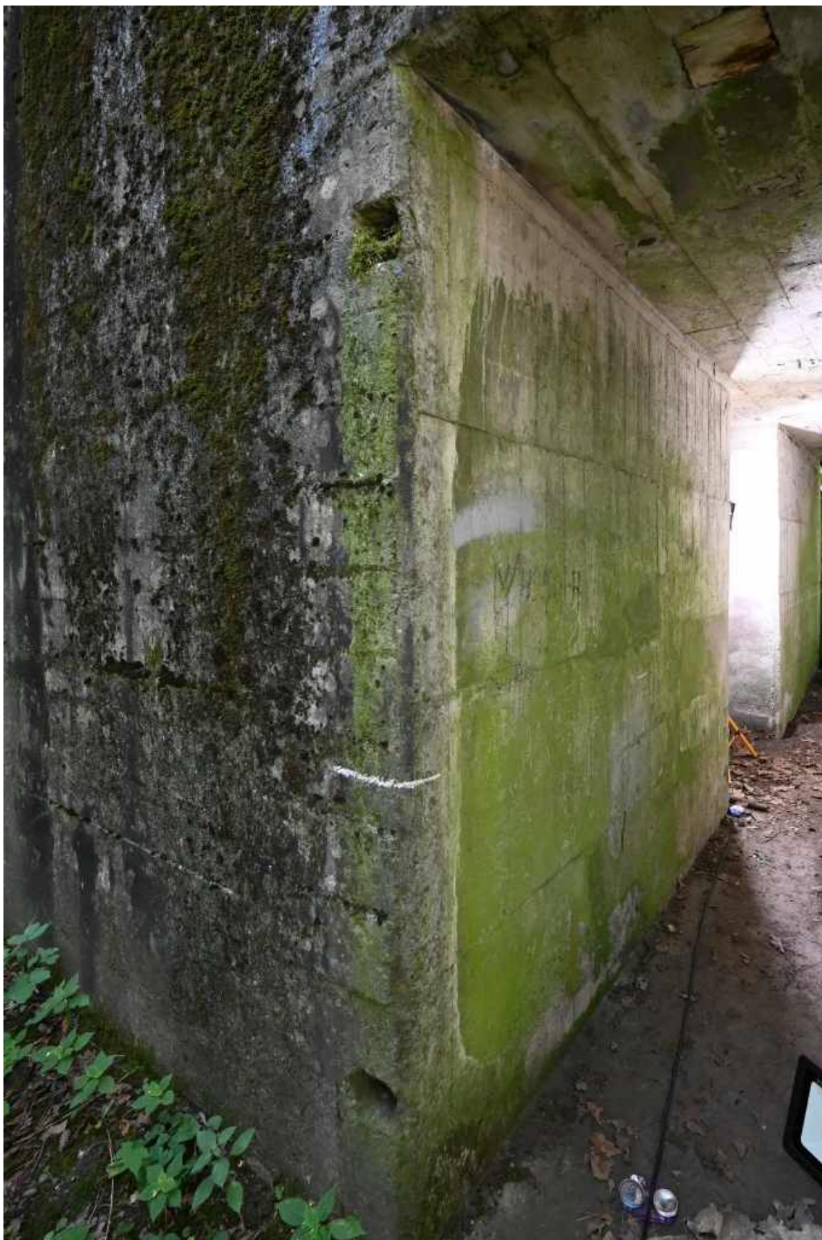
52. Wejście północne, otwory po drewnianych kubikach służących do zamontowania zawiasów drzwi (prawdopodobnie drewnianych).
