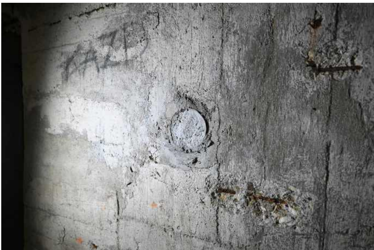
76. Ściana południowa przedsionka, wtórnie wykuty otwór na rurę, która została później obcięta i zamurowana.
