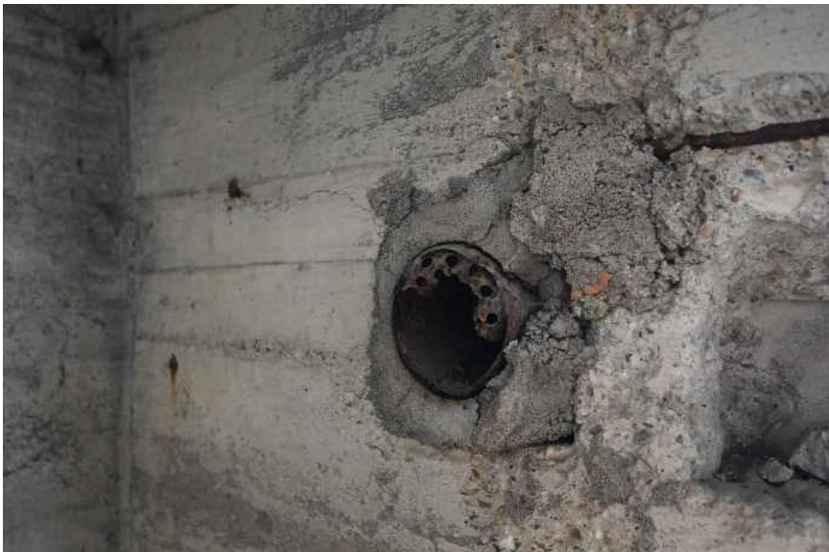
75. Wtórne wykucie i rura poprowadzona z przedsionka do komory schronowej.
