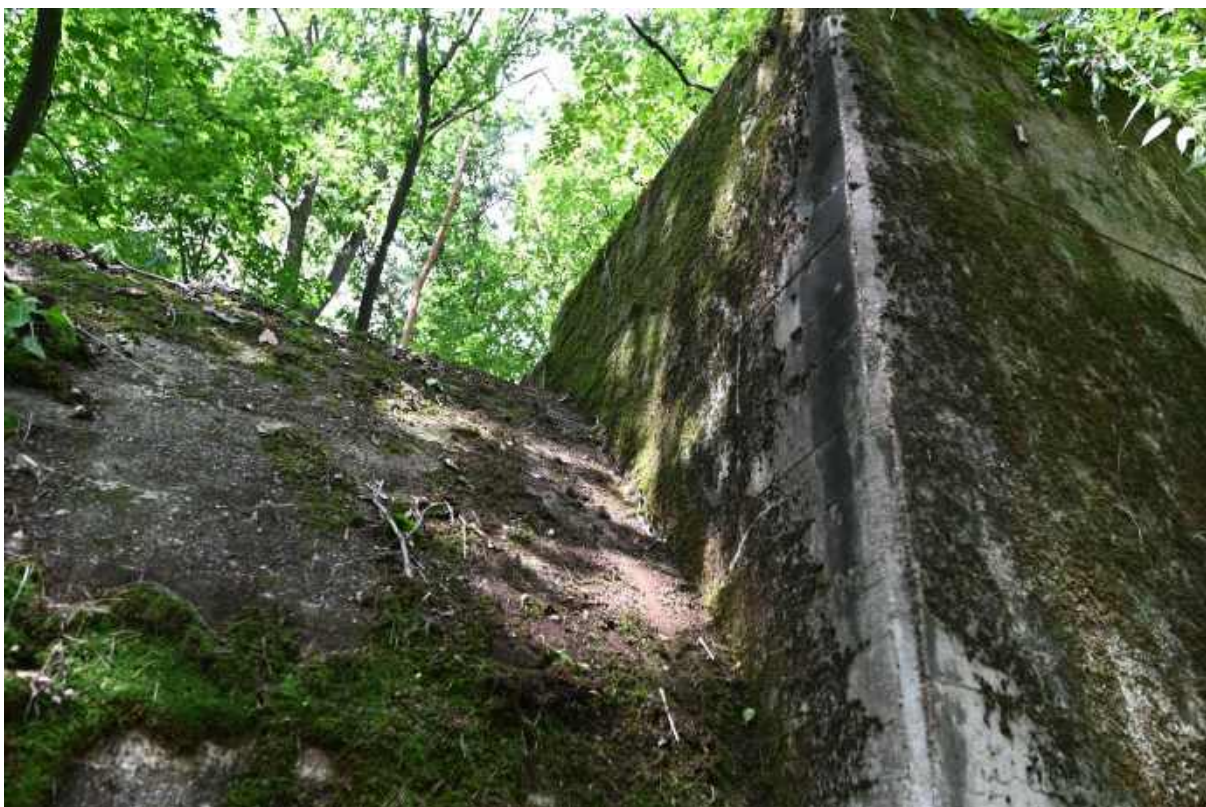
33. Fragment elewacji wschodniej, miejsce łączenia budynku wejściowego i komory schronowej.
