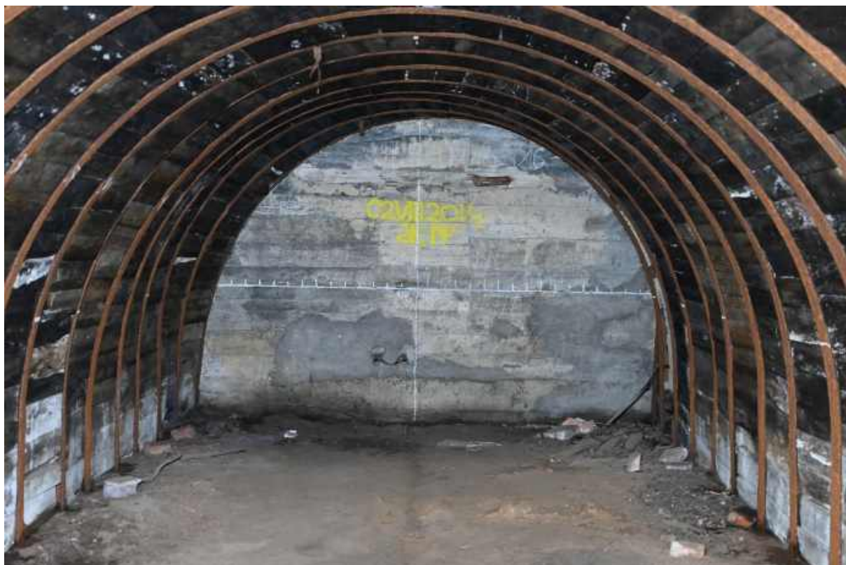
87. Ściana południowa komory schronowej, widoczne łąty betonowe, deska w górnej części ściany, podstawa urządzenia filtrowentylacyjnego, oraz ślady wandalizmu.
