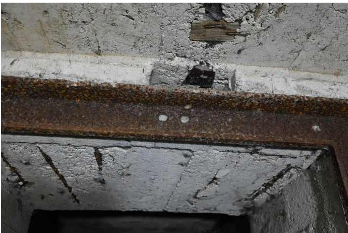
66. Górna część ościeżnicy z niewykorzystanymi otworami do mocowania w murze; nad ościeżnicą kanał na przewody elektryczne.
