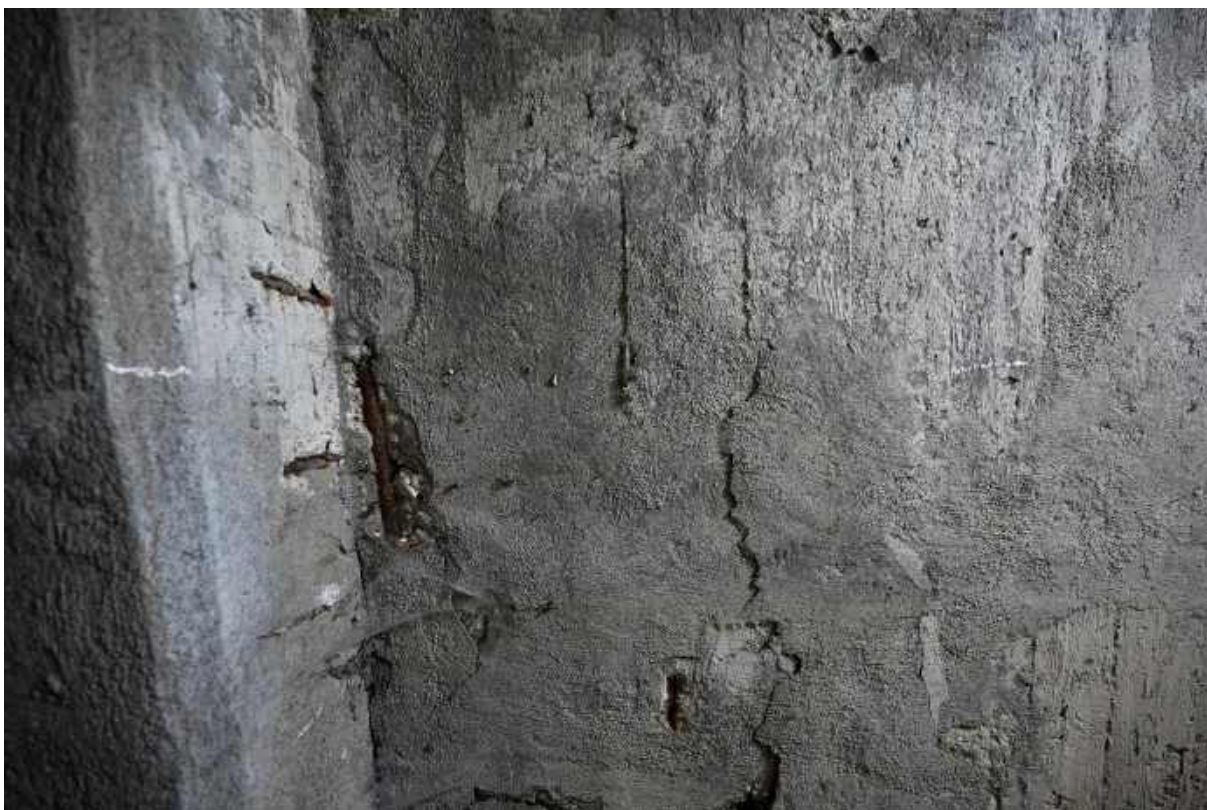
81. Ściana północna przedsionka, przy przejściu do przelotni, widoczne wtórne łąty betonowe obok odsłoniętego zbrojenia.
