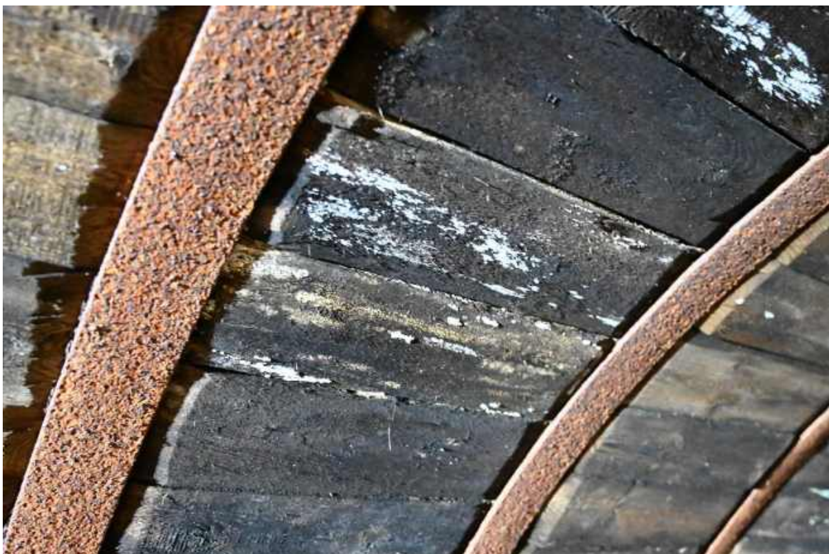
117. Ściana komory schronowej, spleśniałe i silnie zawilgocone deski szalunku.
