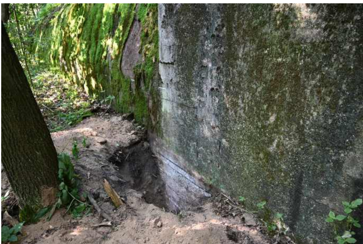
29. Fragment elewacji wschodniej (budynek wejściowy), odkop sondażowy przy fundamencie.
