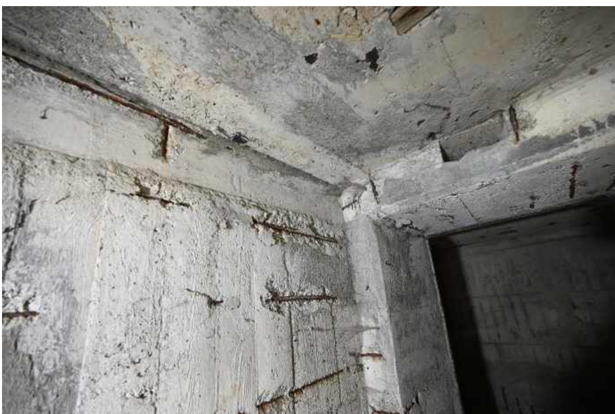
78. Ściana południowa przedsionka, licznie odsłonięte pręty zbrojeniowe. W tle przejście do przelotni z kanałem na kable.
