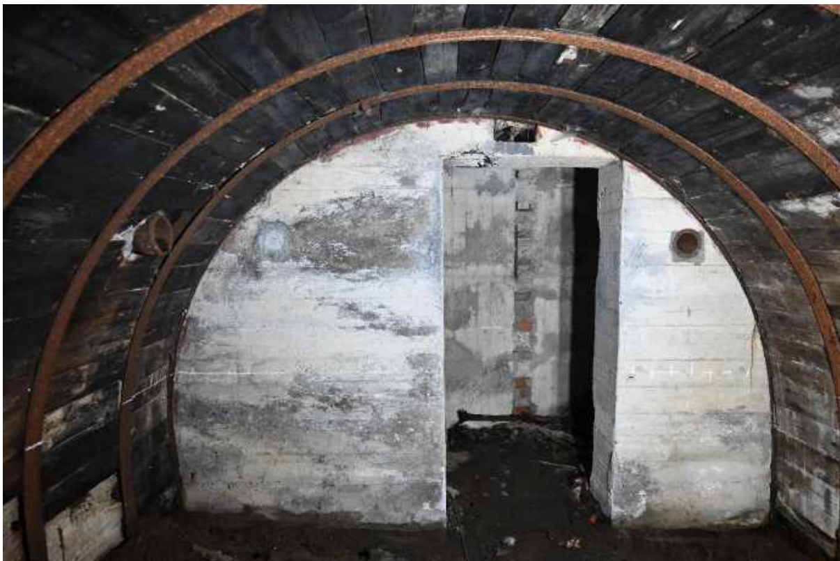
99. Ściana północna z przejściem do przedsionka, od lewej: zamurowana rura, otwór nad przejściem do poprowadzenia instalacji elektrycznej, nieokreślony, wtórny otwór z rurą łączącą przedsionek i komorę schronową.
