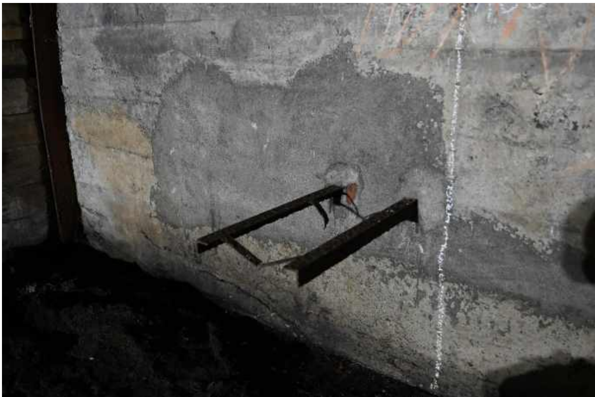
89. Ściana południowa, podstawa urządzenia filtrowentylacyjnego.
