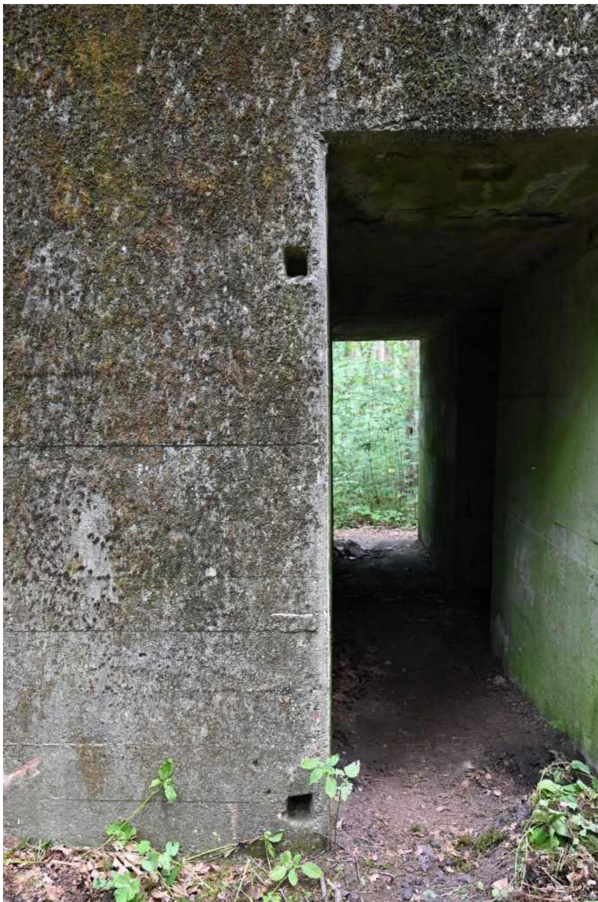
55. Wejście południowe, otwory po drewnianych kubikach służących do zamontowania zawiasów drzwi (prawdopodobnie drewnianych).
