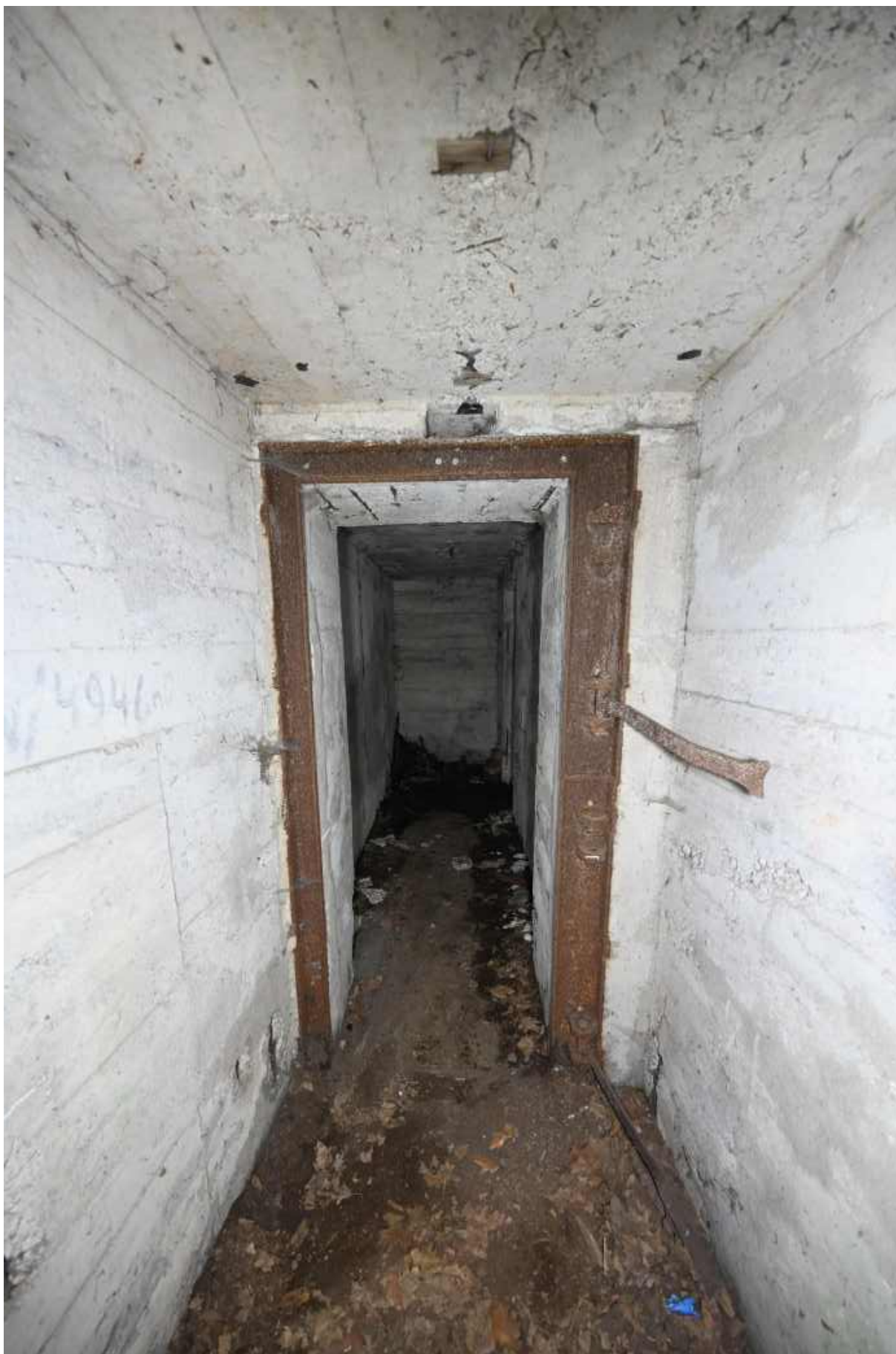
61. Przejście do przedsionka, ościeżnica stalowa ciężkich drzwi gazoszczelnych.
