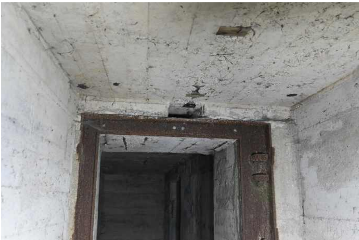
65. Górna część ościeżnicy; nad ościeżnicą kanał na przewody elektryczne.
