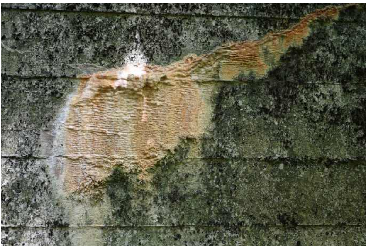
112. Szczelina z wyraźnym wysoleniem.
