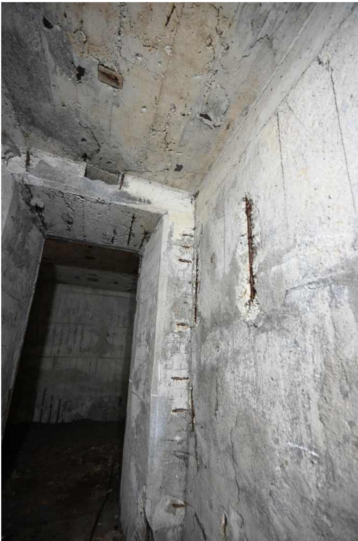
110. Ściany przedsionka wymagające wzmocnienia strukturalnego i uzupełnianie ubytków.
