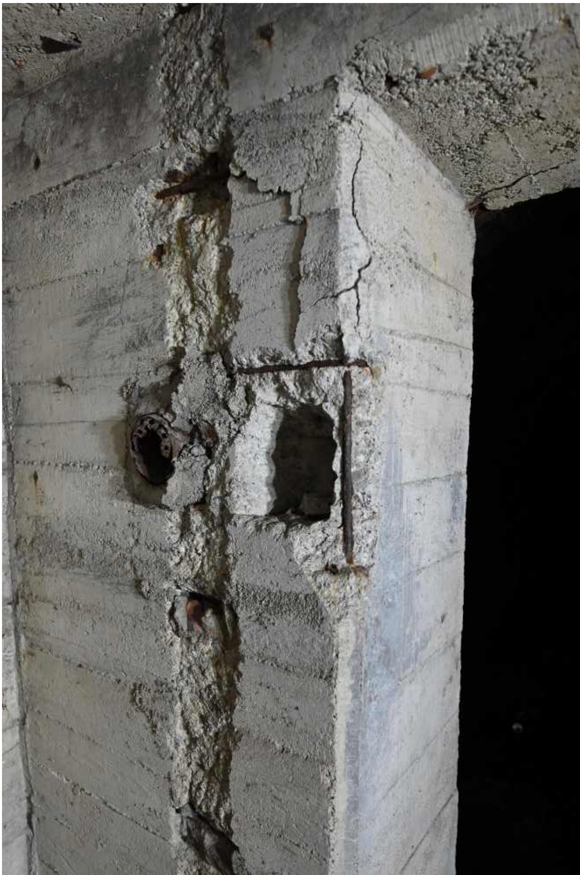
74. Ściana południowa przedsionka, widoczny relikwyt wtórnej ściany ceglanej, gniazda po drewnianych mocowaniach zawiasów oraz odsłonięte zbrojenia. W tle wtórne wykucie i rura poprowadzona z przedsionka do komory schronowej.
