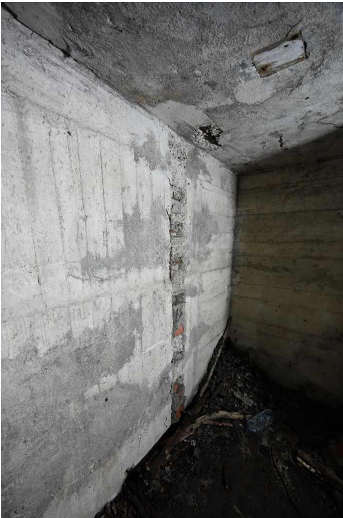
72. Ściana północna przedsionka, widoczne łaty betonowe oraz relikty wtórnej ścian ceglanych, w suficie deseczka wykorzystywana prawdopodobnie do zamocowania lampy.
