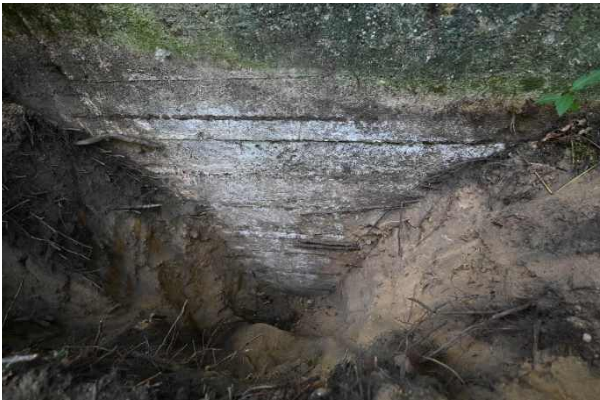
31. Fragment elewacji wschodniej (budynek wejściowy), odkop sondażowy przy fundamencie.
