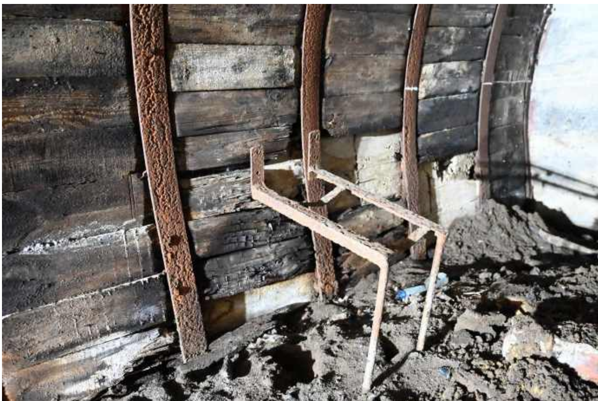
104. Ściana północna, podstawa urządzenia filtrowentylacyjnego.
