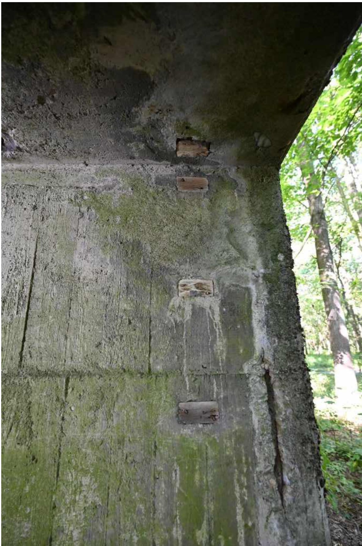
56. Deseczki wmontowane w mur betonowy służące do zamocowania instalacji elektrycznej (oświetleniowej) – kabla, puszki (na suficie) oraz włącznika.
