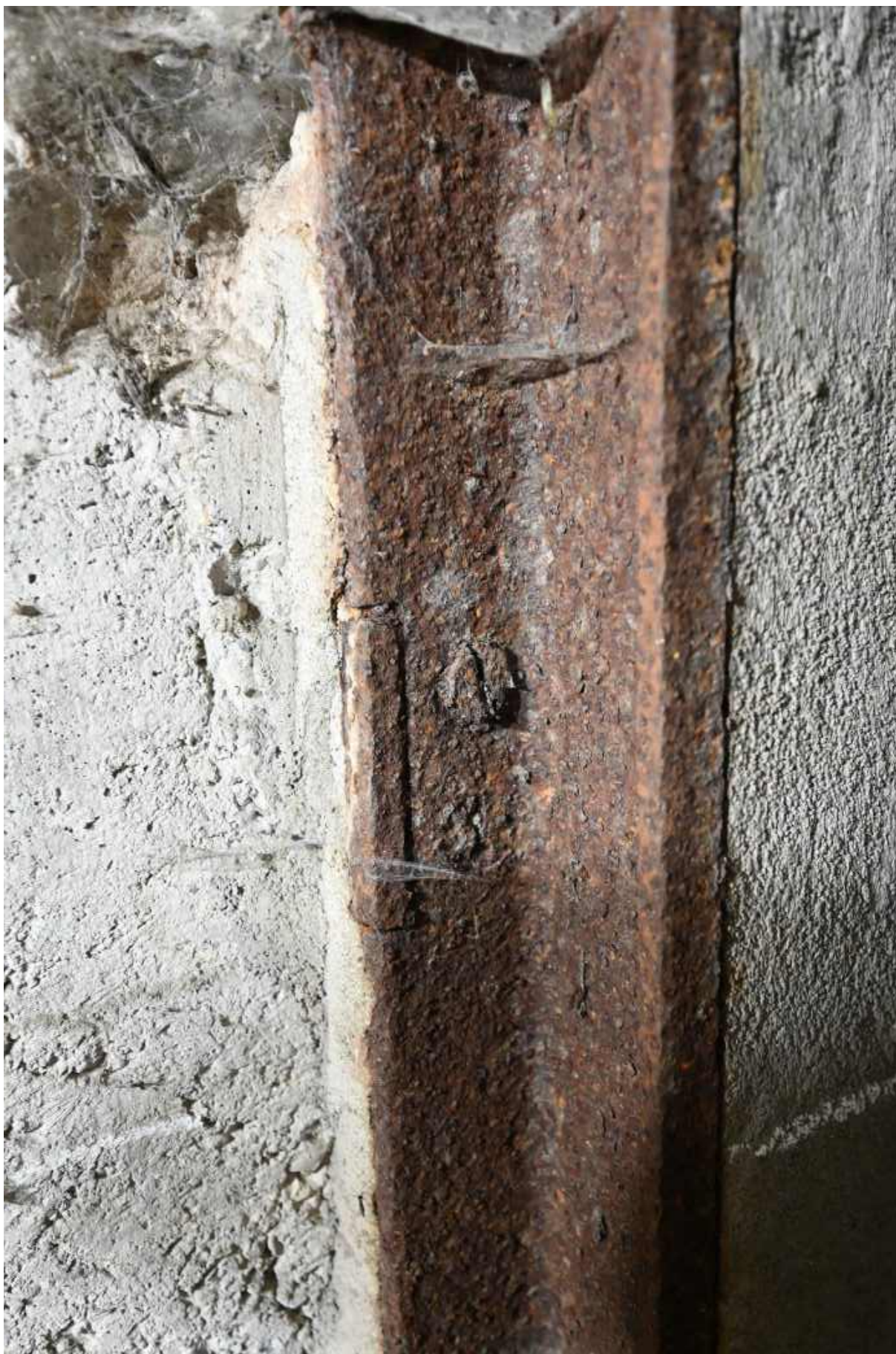
63. Profil ościeznicy oraz sposób mocowania ościeznicy w murze.
