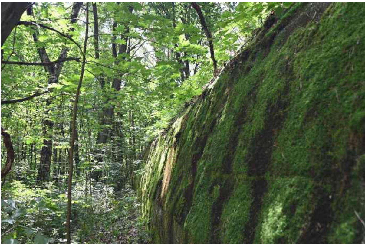
107. Elewacja komory schronowej, roślinność do bezwzględnego usunięcia.
