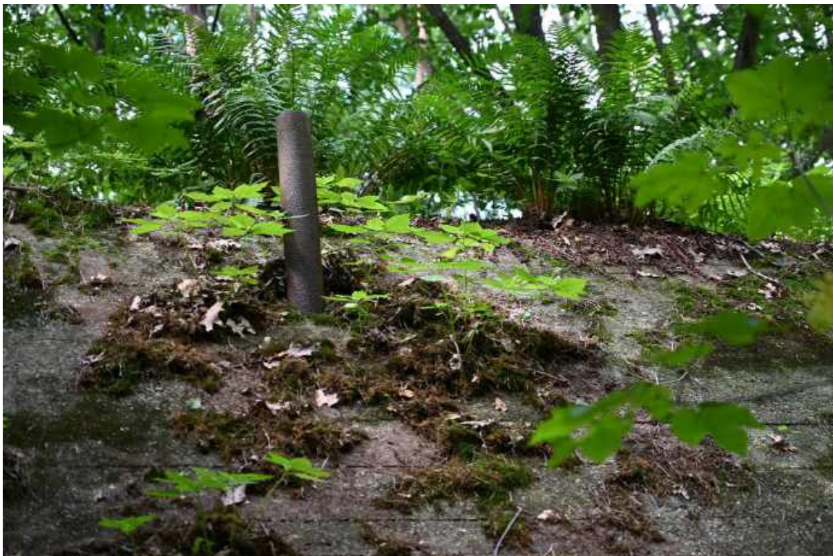
45. Pozostałość rury wylotowej/wlotowej na komorze schronowej.
