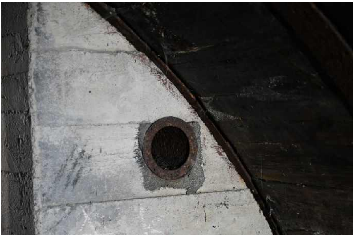
101. Ściana północna komory schronowej, wtórnie wykuty otwór na rurę prowadzą z komory schronowej do przedsionka.
