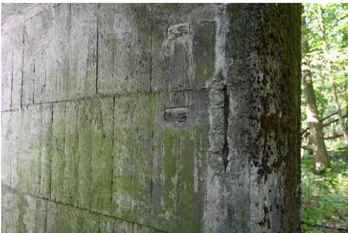
108. Przelotnia, nalot wymagający usunięcia.
