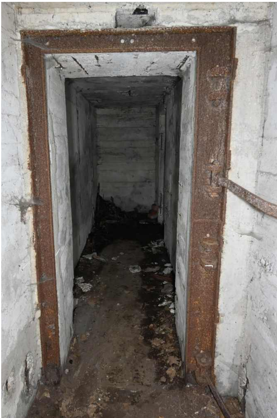
114. Ościeżnica ciężkich drzwi gazoszczelnych wymagająca oczyszczenia i zabezpieczenia.
