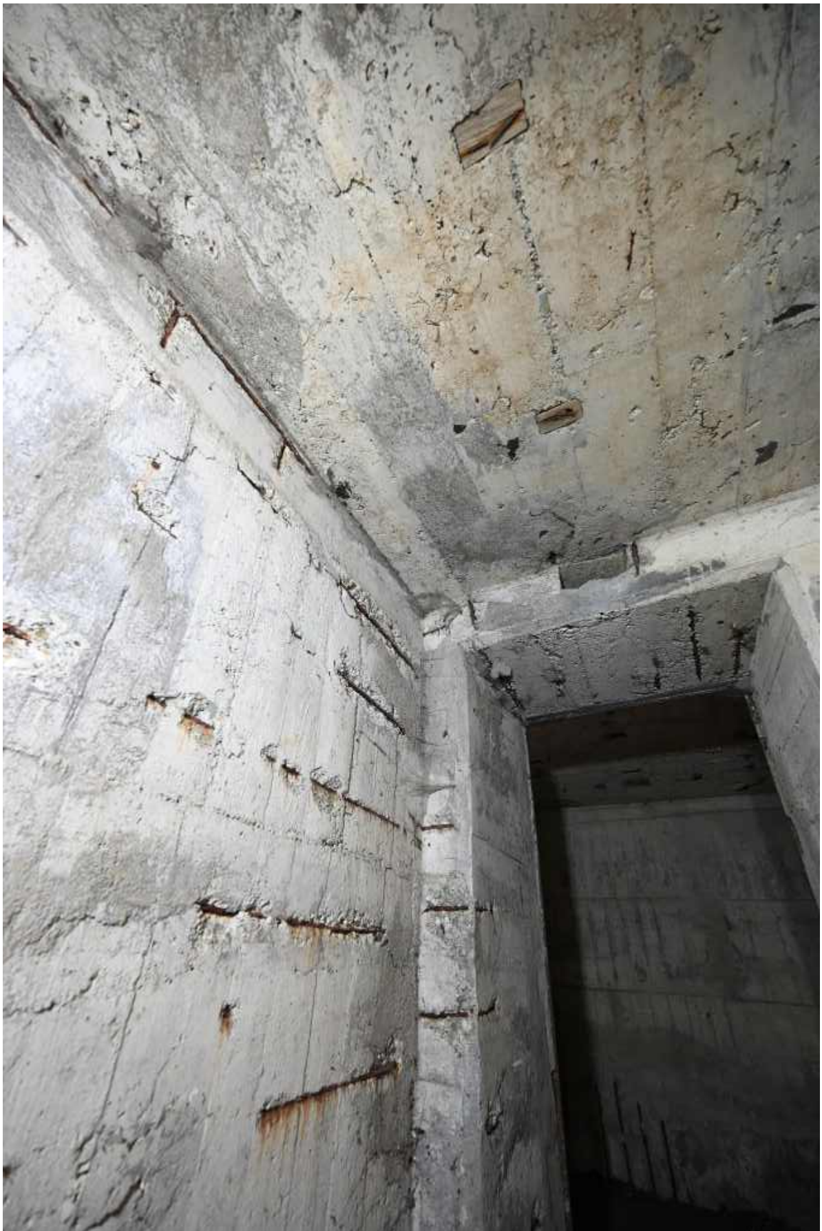
109. Ściany przedsionka wymagające wzmocnienia strukturalnego i uzupełnienia ubytków.
