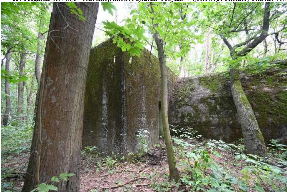
34. Fragment elewacji zachodniej, miejsce łączenia budynku wejściowego i komory schronowej.
