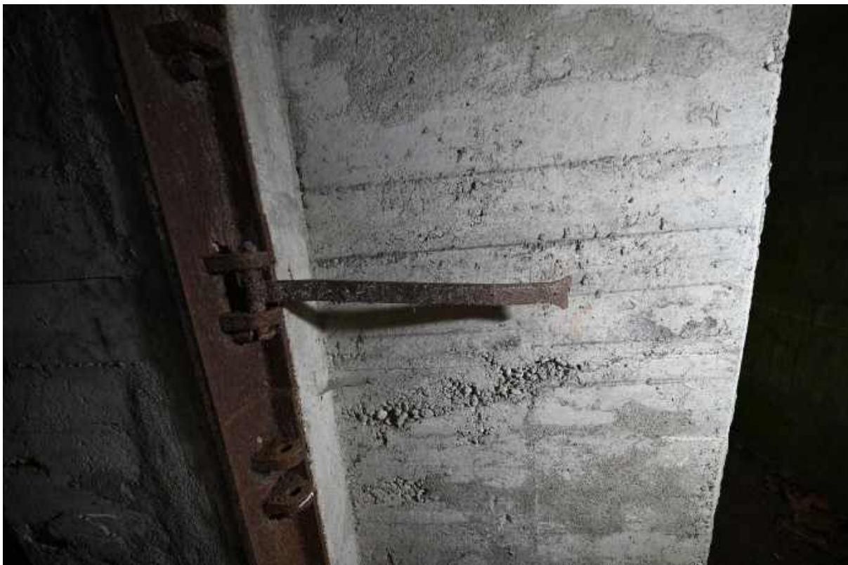
68. Mocowanie zawiasu z okuciem (prawdopodobnie wtórnym lub tymczasowym).
