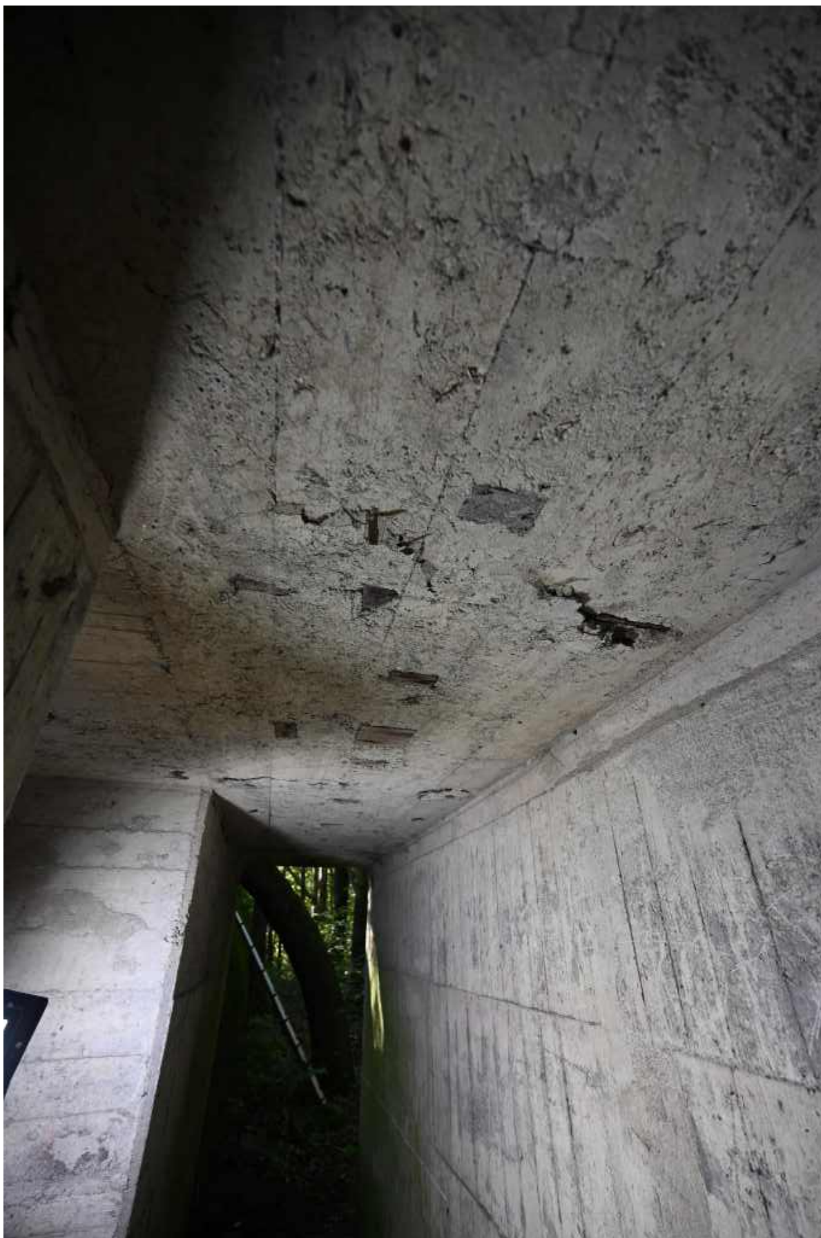
57. Sufit przelotni, deseczki wmontowane w mur betonowy służące do zamocowania instalacji elektrycznej (oświetleniowej) – kabla oraz puszeki.
