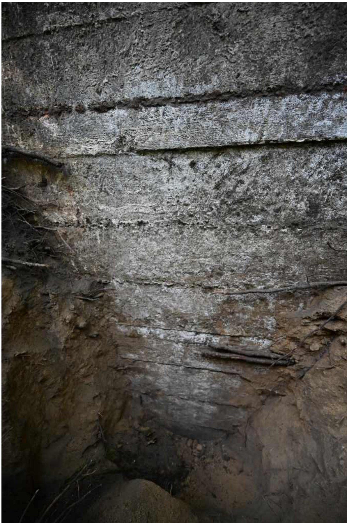
30. Fragment elewacji wschodniej (budynek wejściowy), odkop sondażowy przy fundamencie.
