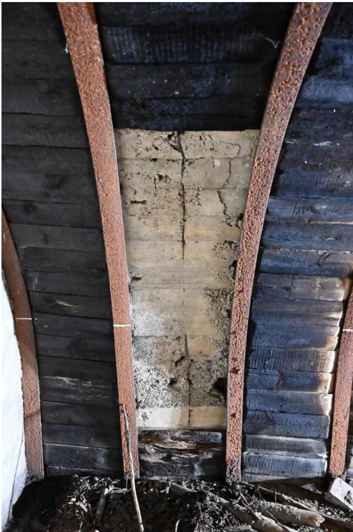
91. Wybrakowane miejsce, odsłonięte lico betonowe ściany komory schronowej.
